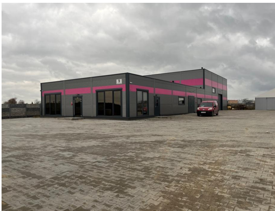
Zdjęcie nr 26. Budynek produkcyjno-magazynowy w Budzynie (fot. Magdalena Hojan).
