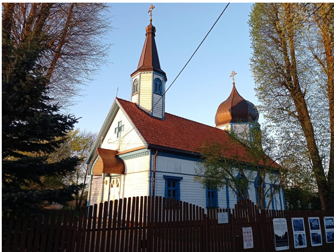
Ryc. 46. Cerkiew pw. Zaśnięcia Najświętszej Marii Panny w Wojnowie (fot. D. Grzybek)
