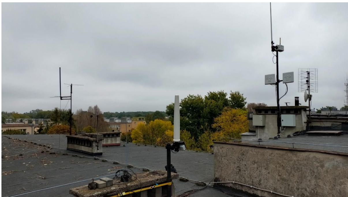
Rys. 2. Miejsce montażu SMS PEM – Urząd Miasta Pruszków – widok na SBTk
