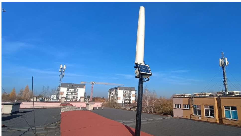
Rys. 2 Miejsce montażu SMS PEM – SP nr 16 w Siemianowicach – widok na SBTK
