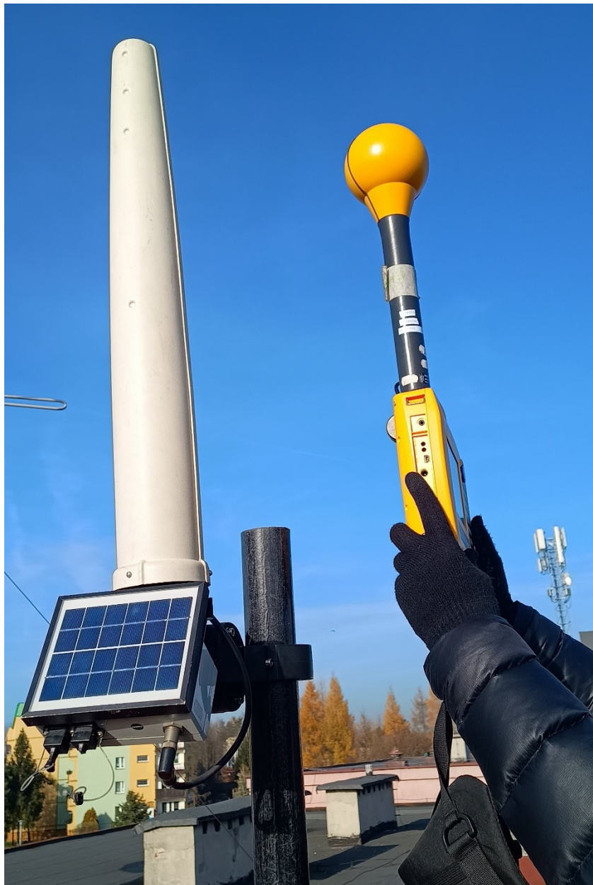
Rys. 7 SP nr 16 w Siemianowicach – pomiary selektywne SRM-3600
