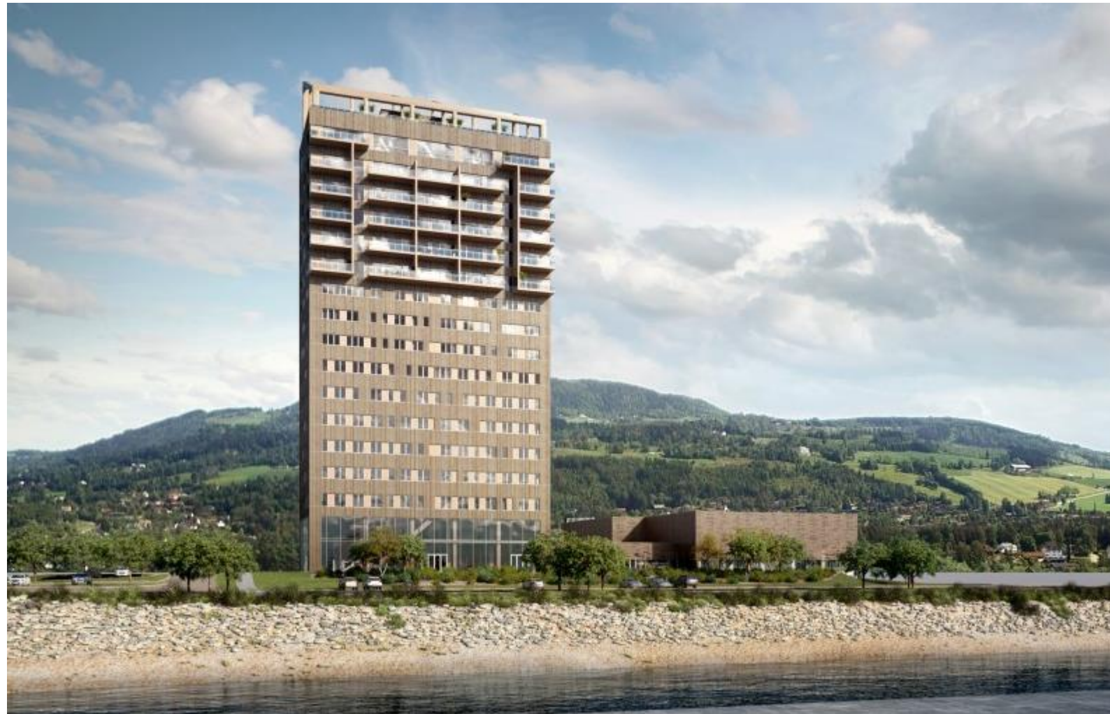
84.5 m, 18 piętrowy. Mjøsa Tower o konstrukcji drewnianej. Brumunddal (11k), Norwegia
