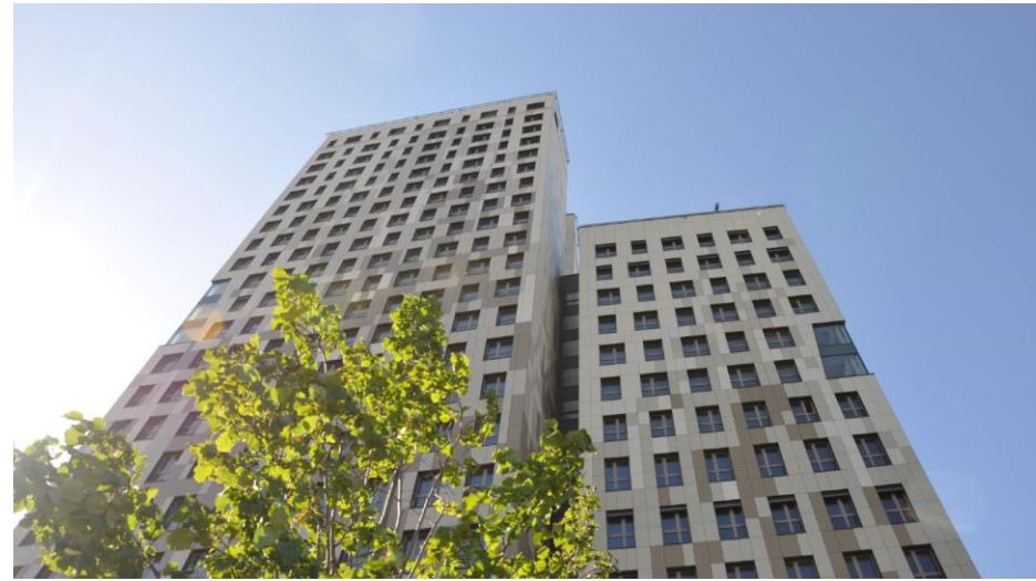
HoHo Vienna Tower. 84 m, 24 piętra. Elewacja i wnętrze budynku 75% - drewno
