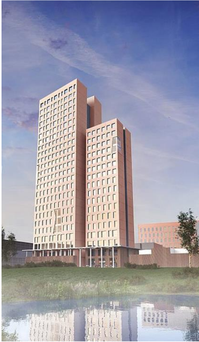
HoHo Vienna Tower. 84 m, 24 piętra. Elewacja i wnętrze budynku 75% - drewno
