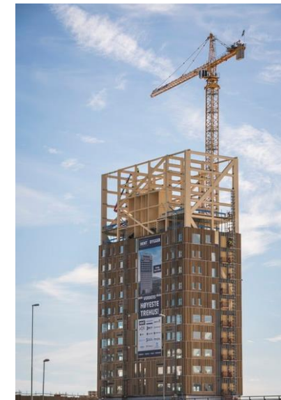
84.5 m, 18 piętrowy. Mjøsa Tower o konstrukcji drewnianej. Brumunddal (11k), Norwegia
