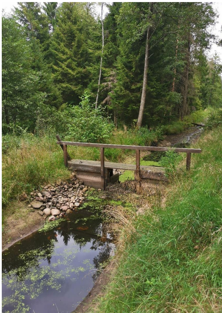
Ryc. 45. Zastawka na cieku wodnym na terenie Leś. Sajenek (fot. P. Kalisz)
