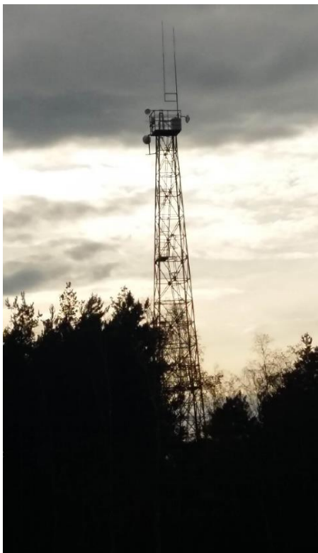
Zdjęcie 1. DOSTRZEGALNIA PRZECIWOPOŻAROWA Z UMIESZCZONĄ NA WIERZCHOŁKU KAMERĄ.
