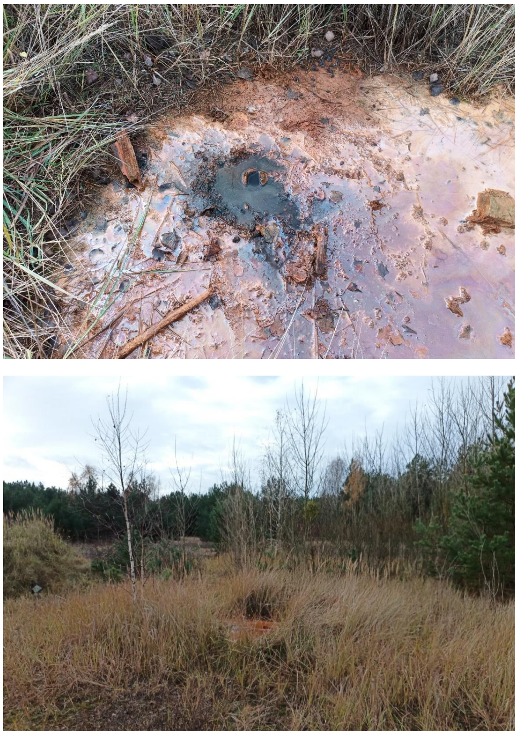
Rys. 12. Aktualny stan wylotu otworu Gostynin 8 (fot. K Pióro)
