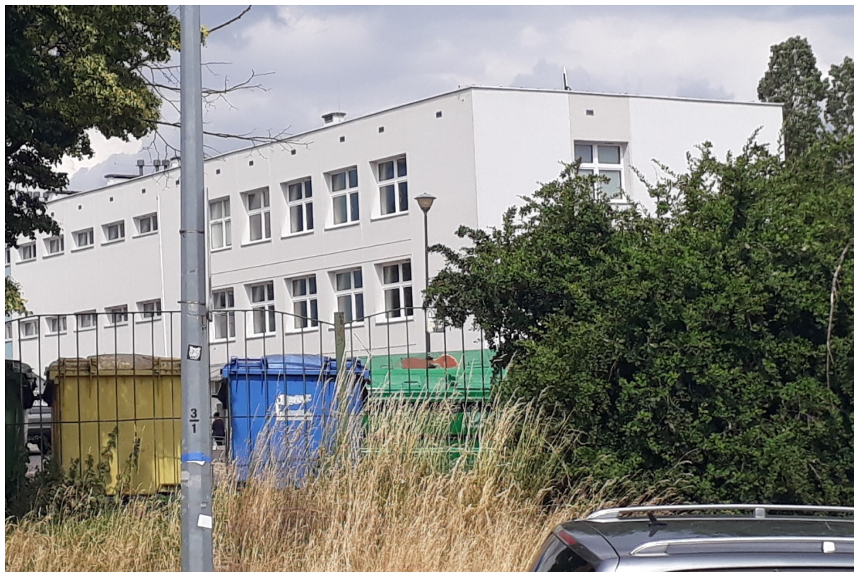
Rys. 2 Miejsce montażu SMS PEM – Zespół Szkolno-Przedszkolny nr 2 w Gdyni – widok z poziomu gruntu
