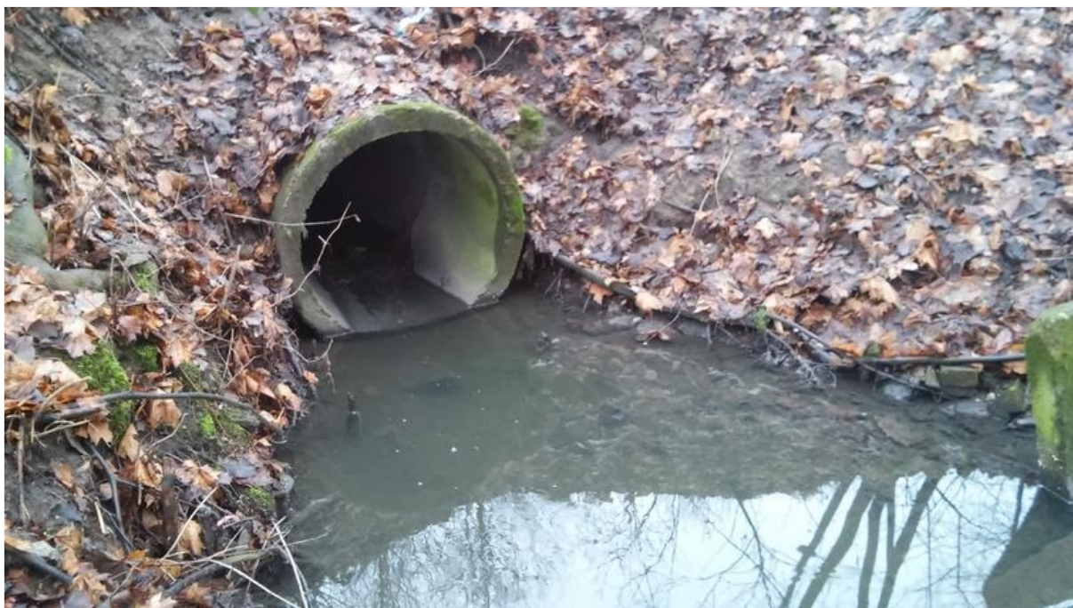
Fot. 12. Ścieki szare tuż za przepustem pod torami i drogą przy ul. Dalkoskiej 18
