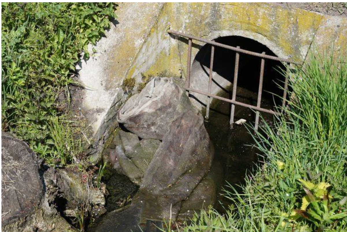
Fot. 6. Śmieci czopujące przepływ na Gnieźnieńskiej Strudze przed wpływem do przepustu pod torami 16
