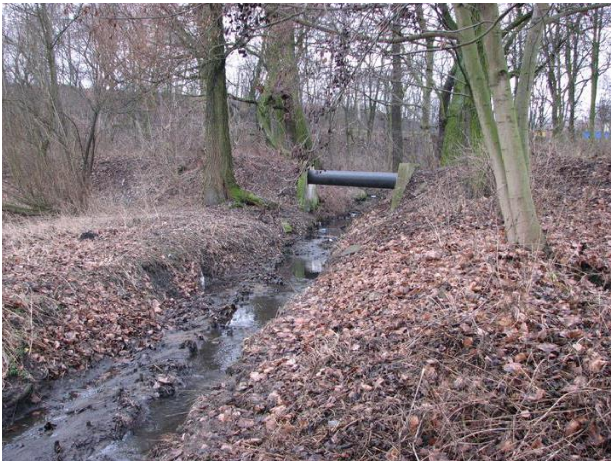
Fot. 14. Rura kanalizacji ogólnospławnej przecinająca Strugę Gnieźnieńską
