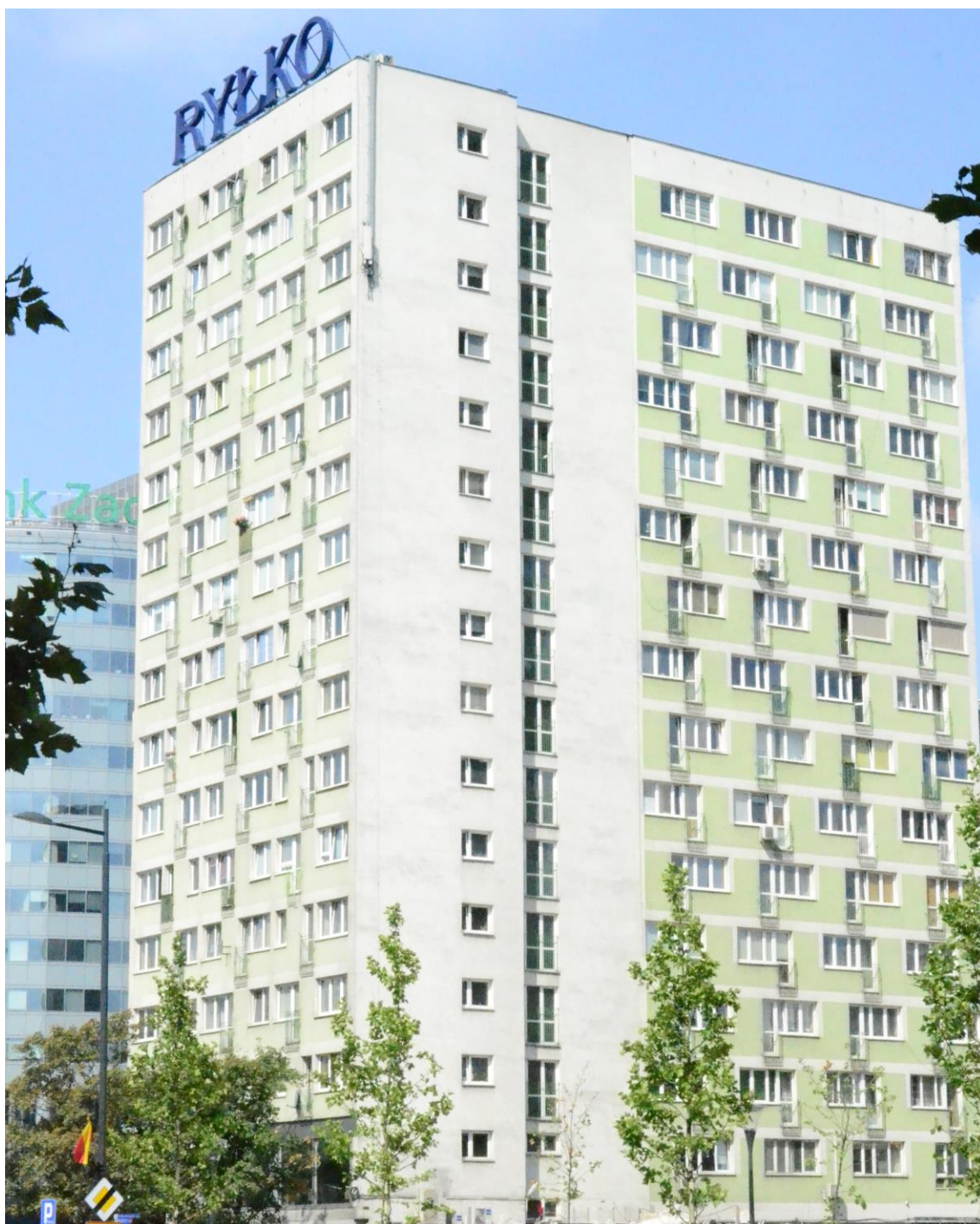
Fot. 2: Widok anteny stacji bazowej ID: BT11100, zlokalizowanej przy Al. Jana Pawła II 18 w Warszawie
