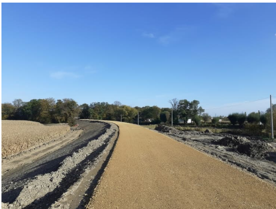
Foto. 53. Budowa drogi na koronie wału przeciwpowodziowego – prawy wał Wisły na odcinku 3.2a, stan w drugiej dekadzie października 2022 r. (widok w dół rzeki).
