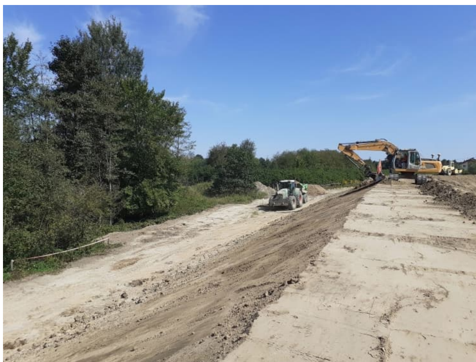
Foto. 48. Wyrównywanie skarp wału przeciwpowodziowego – prawy wał Wisły na odcinku 3.4, stan w pierwszej dekadzie września 2022 r. (widok w dół rzeki).
