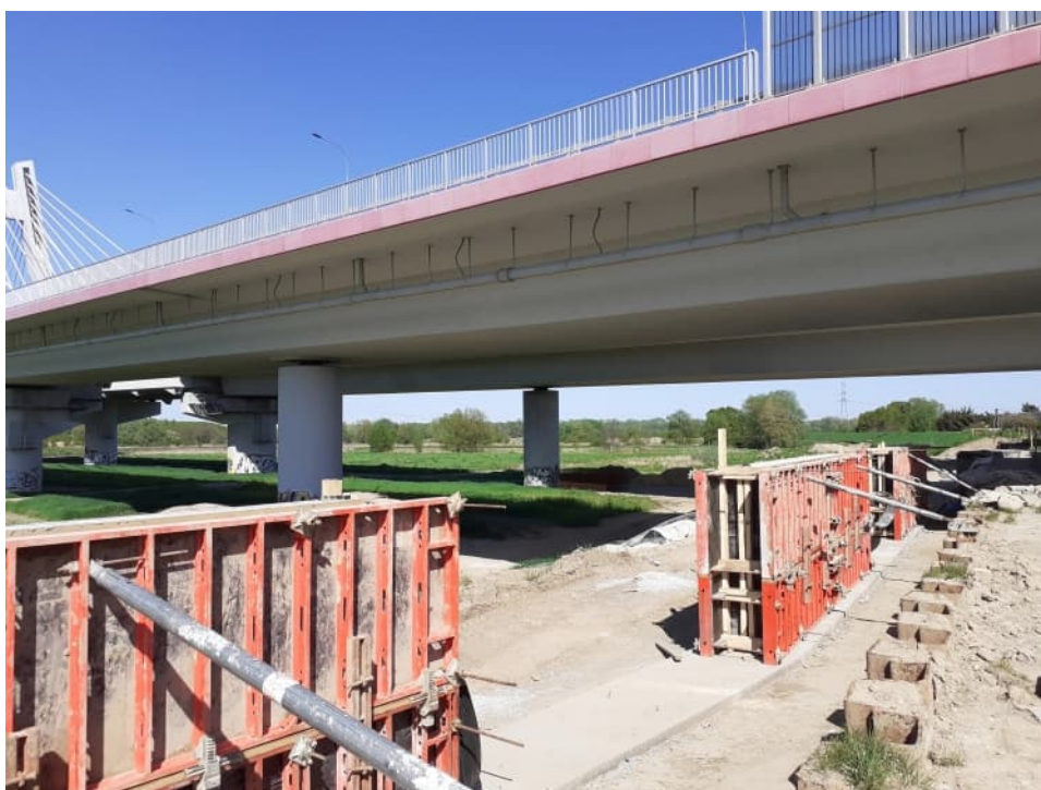
Foto. 40. Budowa muru oporowego – prawy wał Wisły na odcinku 3.3, stan w pierwszej dekadzie maja 2022 r. (widok w dół rzeki).
