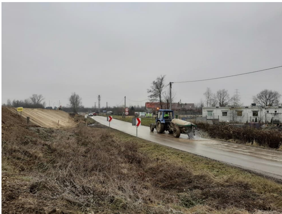
Foto. 28. Utrzymywanie czystości dróg publicznych w sąsiedztwie terenu budowy – prawy brzeg Wisły na odcinku 3.4, stan w trzeciej dekadzie listopada 2022 r. (widok w dół rzeki).
