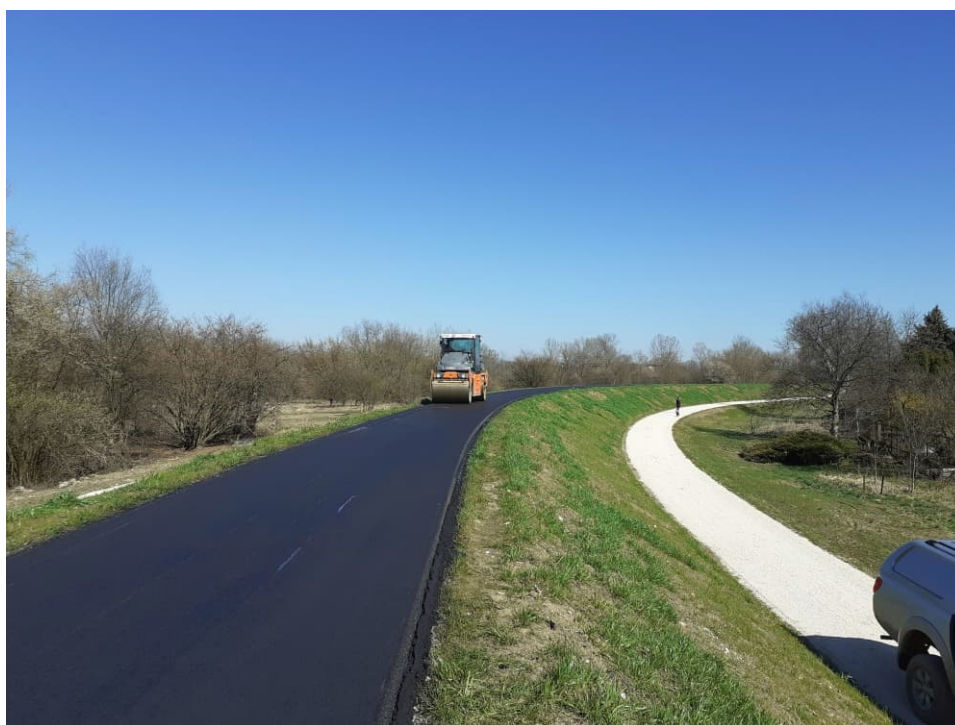
Foto. 54. Budowa drogi na koronie wału przeciwpowodziowego – prawy wał Wisły na odcinku 3.1, stan w trzeciej dekadzie marca 2023 r. (widok w dół rzeki).
