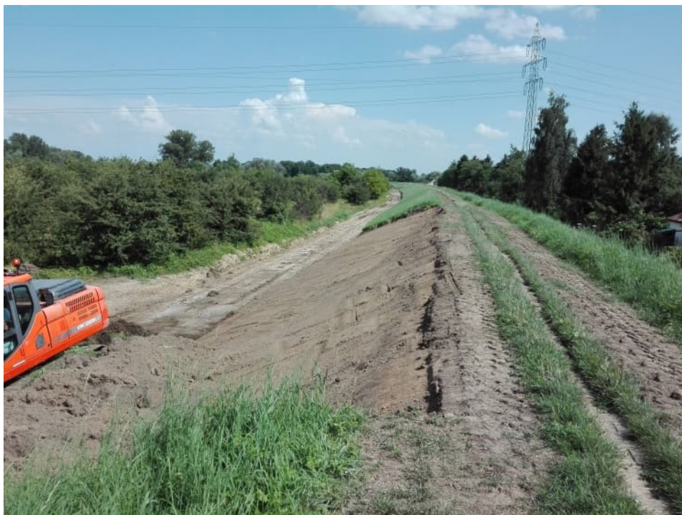
Foto. 30. Zdejmowanie warstwy humusu – prawy wał Wisły na odcinku 3.2a, stan w trzeciej dekadzie lipca 2021 r. (widok w dół rzeki).
