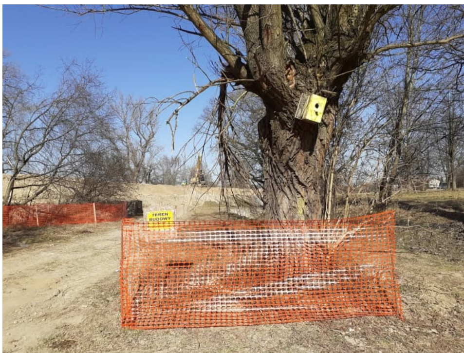
Foto. 23. Zabezpieczenie drzew i krzewów nie planowanych do wycinki – prawy wał Wisły na odcinku 3.2b, stan w trzeciej dekadzie marca 2022 r. (widok w dół rzeki).
