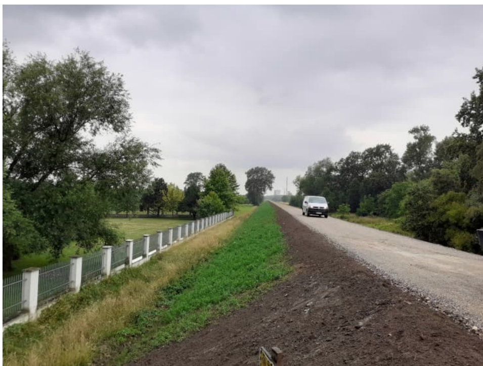
Foto. 55. Porost traw wysianych na skarpie wału przeciwpowodziowego – prawy wał Wisły na odcinku 3.3, stan w drugiej dekadzie lipca 2023 r. (widok w górę rzeki).
