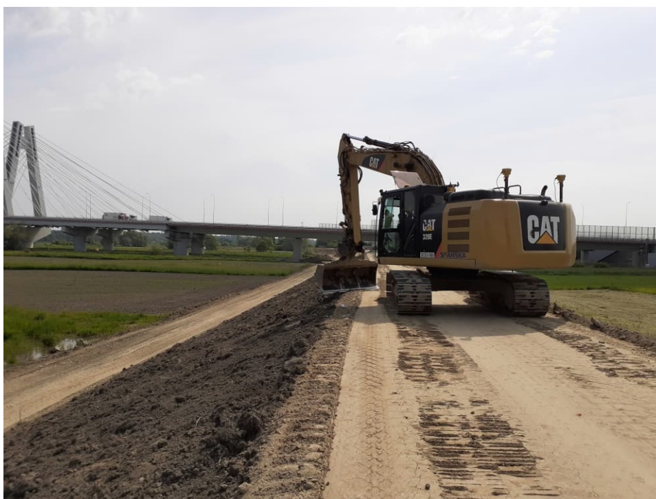
Foto. 52. Humusowanie skarp walu przeciwpowodziowego – prawy wał Wisły na odcinku 3.3, stan w trzeciej dekadzie maja 2023 r. (widok w dół rzeki).
