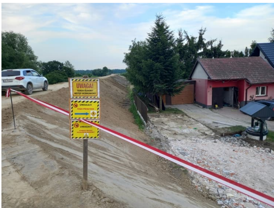
Foto. 20. Zabezpieczenie miejsc niebezpiecznych w sąsiedztwie zabudowań – prawy wał Wisły na odcinku 3.3, stan w trzeciej dekadzie czerwca 2023 r. (widok w dół rzeki).
