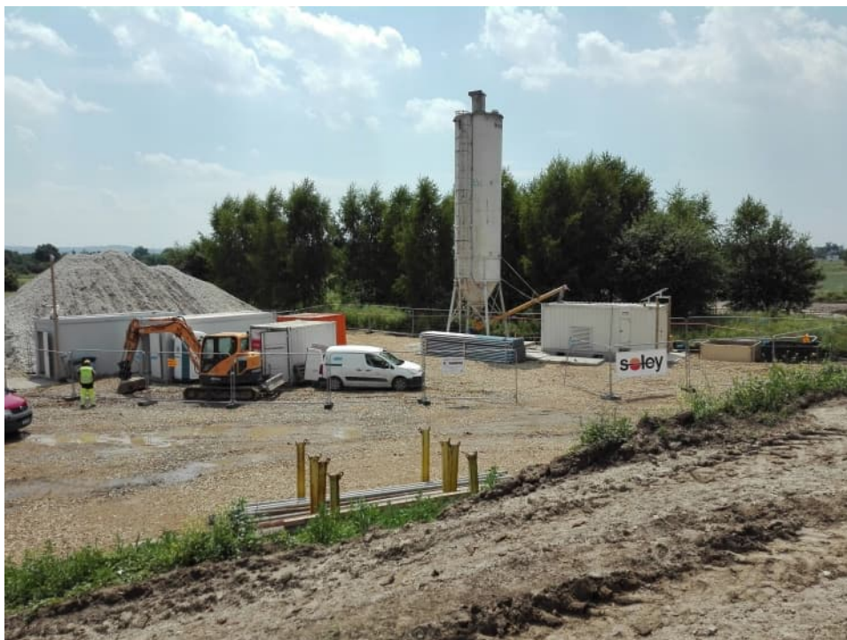
Foto. 34. Instalacja do wytwarzania mieszanki cementowo-bentonitowej – prawy brzeg Wisły na odcinku 3.3, stan w trzeciej dekadzie czerwca 2021 r. (widok w górę rzeki).
