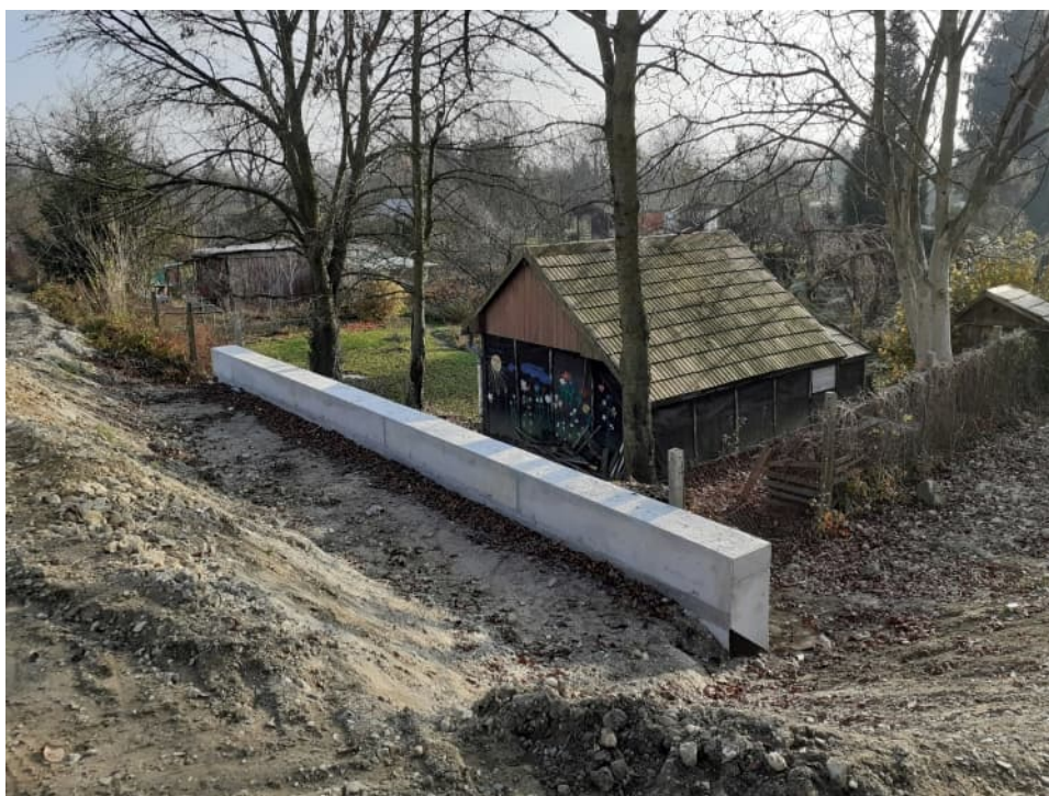
Foto. 39. Budowa muru oporowego – prawy wał Wisły na odcinku 3.2a, stan w drugiej dekadzie listopada 2021 r. (widok w dół rzeki).
