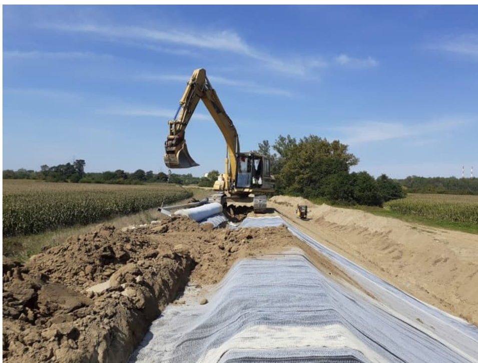
Foto. 49. Układanie bentomaty na skarpie wału przeciwpowodziowego – prawy wał Wisły na odcinku 3.3, stan w pierwszej dekadzie września 2022 r. (widok w górę rzeki).
