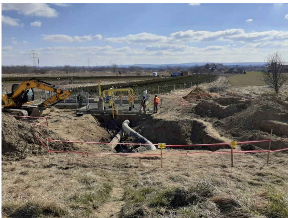
Foto. 42. Prace związane z przebudową sieci gazociągowej – prawy wał Wisły na odcinku 3.3, stan w pierwszej dekadzie marca 2022 r. (widok w kierunku zawala).
