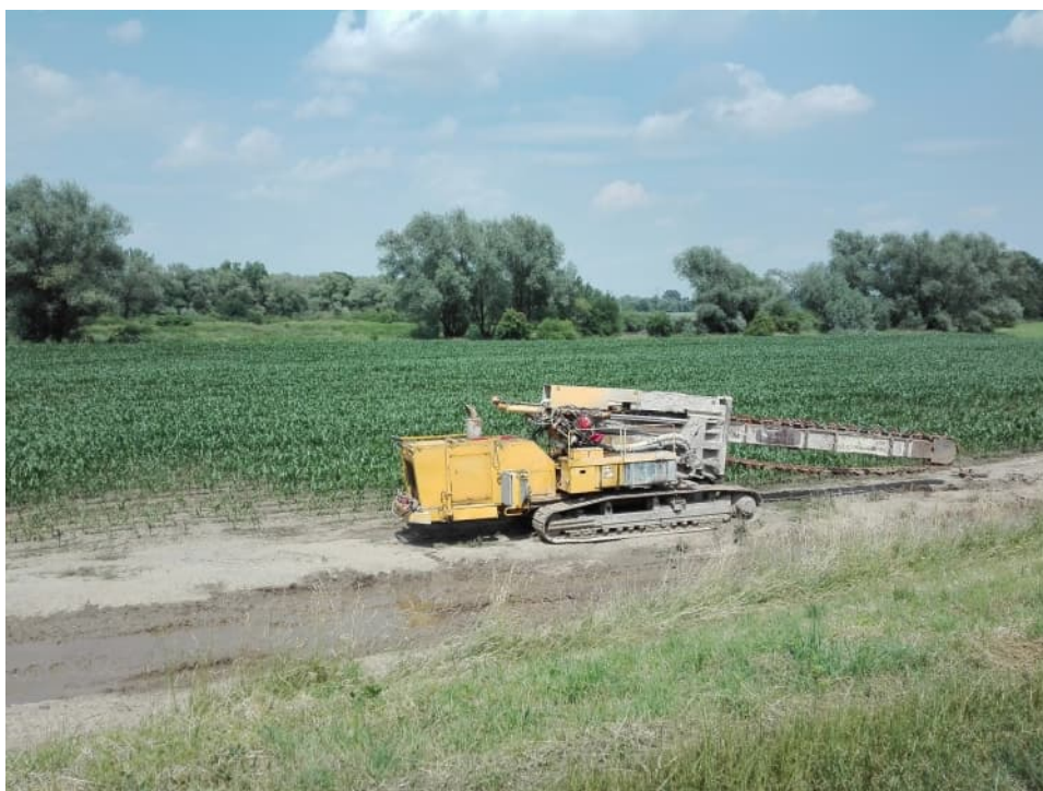
Foto. 33. Budowa przesłony cementowo-bentonitowej u podstawy wału – prawy wał Wisły na odcinku 3.2a, stan w trzeciej dekadzie czerwca 2021 r. (widok w dół rzeki).
