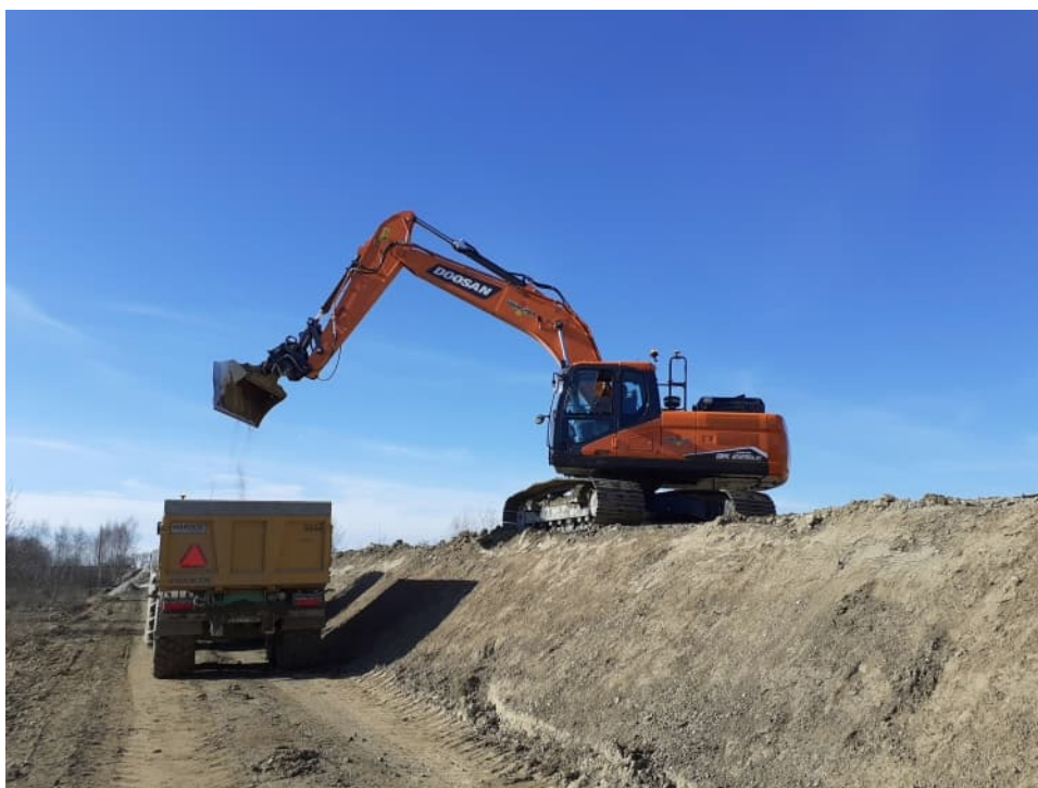
Foto. 47. Wyrównywanie skarp wału przeciwpowodziowego – prawy wał Wisły na odcinku 3.3, stan w trzeciej dekadzie lutego 2022 r. (widok w górę rzeki).
