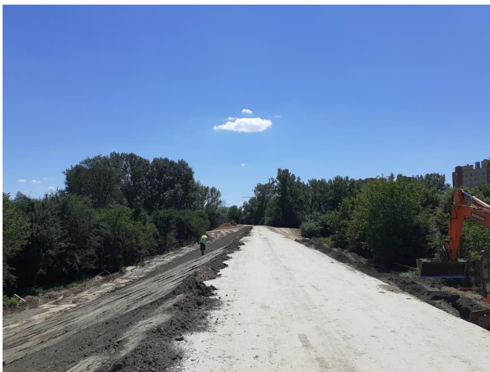
Foto. 51. Humusowanie skarp walu przeciwpowodziowego – prawy wał Wisły na odcinku 3.2a, stan w trzeciej dekadzie czerwca 2022 r. (widok w dół rzeki).
