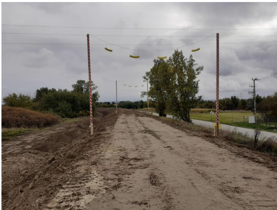
Foto. 18. Zabezpieczenie miejsc niebezpiecznych pod linią energetyczną – prawy wał Wisły na odcinku 3.4, stan w trzeciej dekadzie września 2022 r. (widok w dół rzeki).
