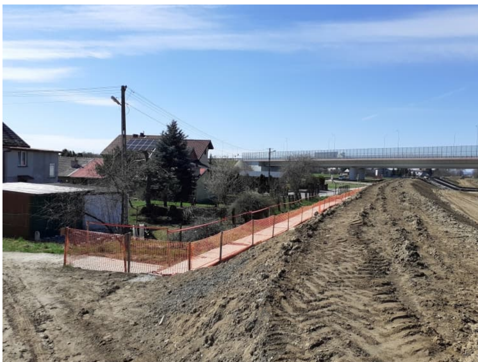
Foto. 19. Zabezpieczenie miejsc niebezpiecznych w sąsiedztwie zabudowań – prawy wał Wisły na odcinku 3.3, stan w trzeciej dekadzie marca 2023 r. (widok w górę rzeki).
