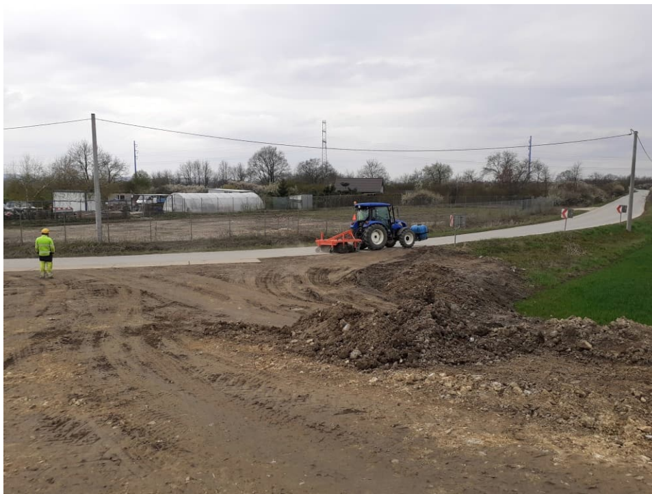
Foto. 27. Utrzymywanie czystości dróg publicznych w sąsiedztwie terenu budowy – prawy brzeg Wisły na odcinku 3.4, stan w drugiej dekadzie kwietnia 2023 r. (widok w kierunku zachodnim).
