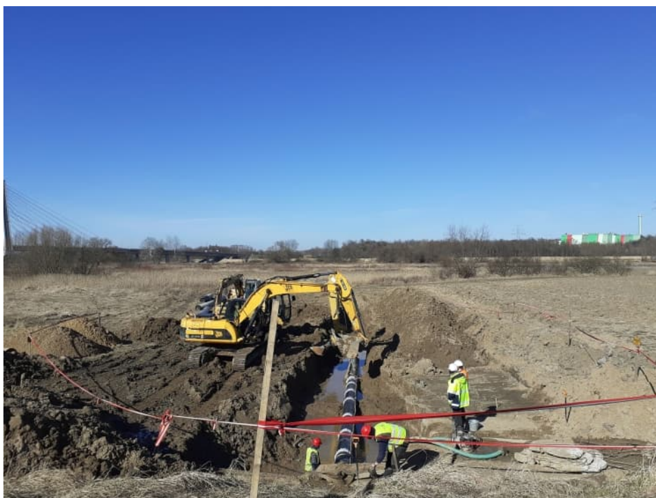
Foto. 41. Prace związane z przebudową sieci gazociągowej – prawy wał Wisły na odcinku 3.3, stan w trzeciej dekadzie lutego 2022 r. (widok w kierunku międzywala).
