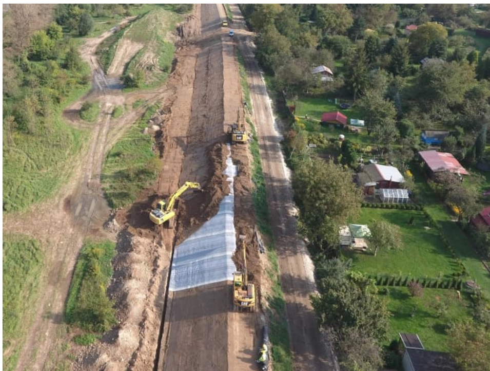
Foto. 50. Układanie bentomaty na skarpie wału przeciwpowodziowego – prawy wał Wisły na odcinku 3.2a, stan w trzeciej dekadzie września 2021 r. (widok w dół rzeki).
