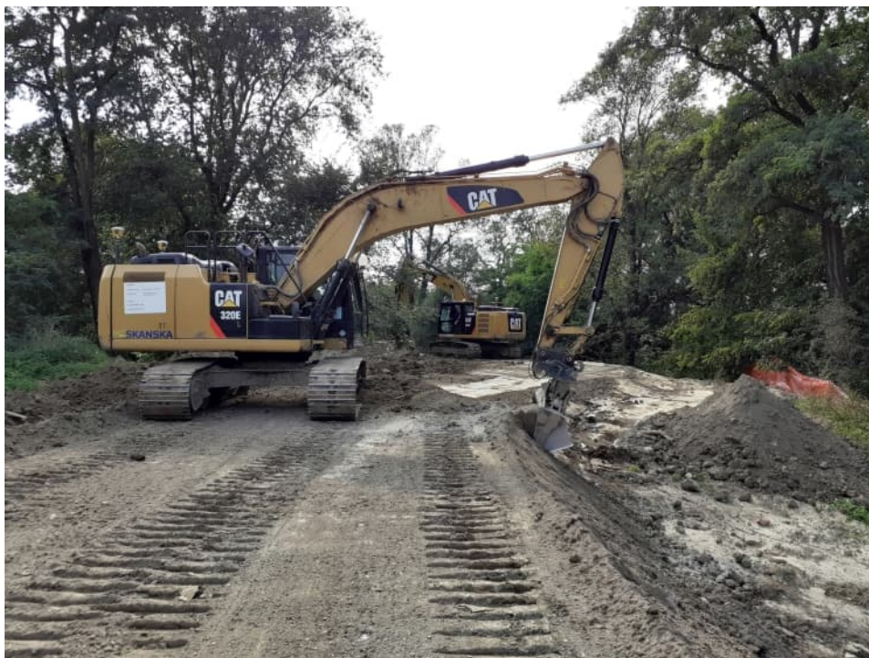
Foto. 46. Formowanie skarp wału przeciwpowodziowego – prawy wał Wisły na odcinku 3.2a, stan w pierwszej dekadzie września 2022 r. (widok w dół rzeki).
