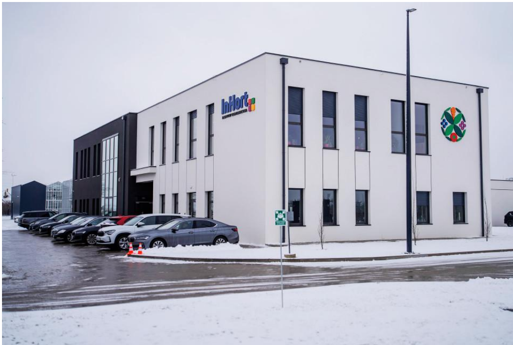
Ryc. Budynek kompleksu laboratoryjno-szklarniowego Instytutu Ogrodnictwa – Państwowego Instytutu Badawczego w Skierniewicach, Miasto Skierniewice
