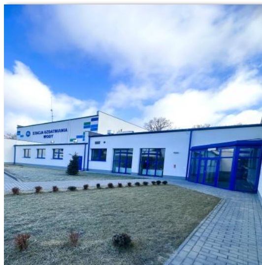
Fot. własna. Stacja uzdatniania wody.
