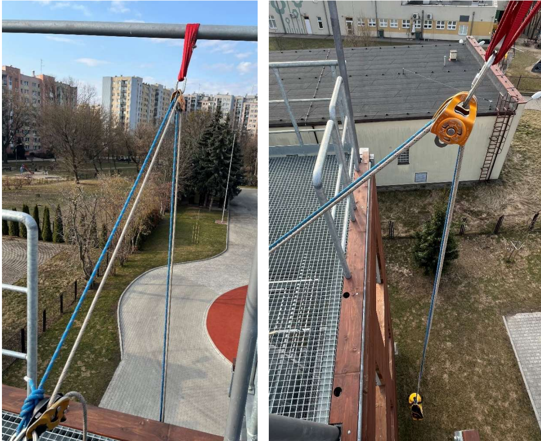
Rys. 11 Przykładowe użycie bloczka w celu ominięcia krawędzi
