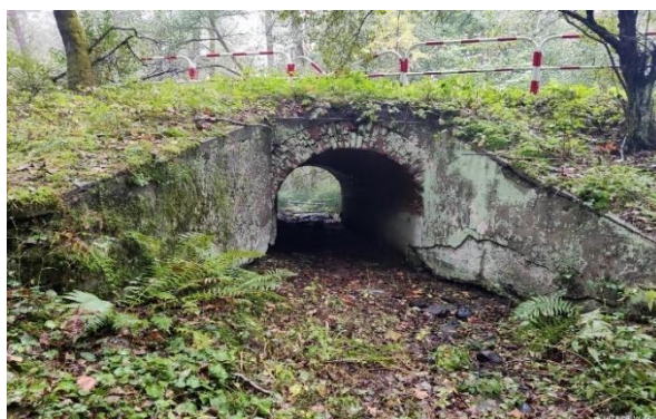
Fotografia 40 Stary przepust drogowy, leśnictwo Złotowo, oddział 213
