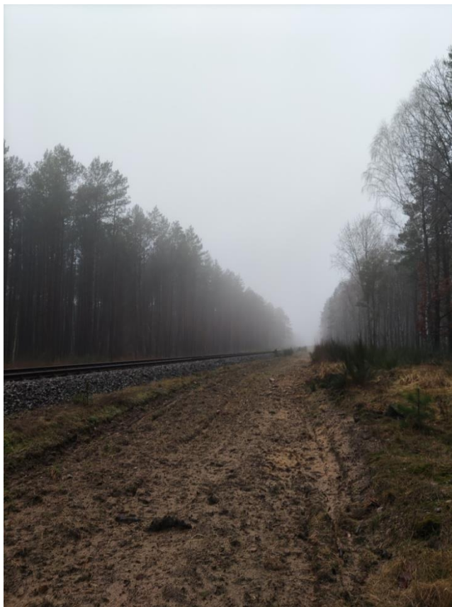
Fotografia 43 Linia kolejowa nr 403 wraz z pasem ppoż typu BK w okolicy przystanku kolejowego Jezioroki Waleckie (fot. Maciej Wałach)
