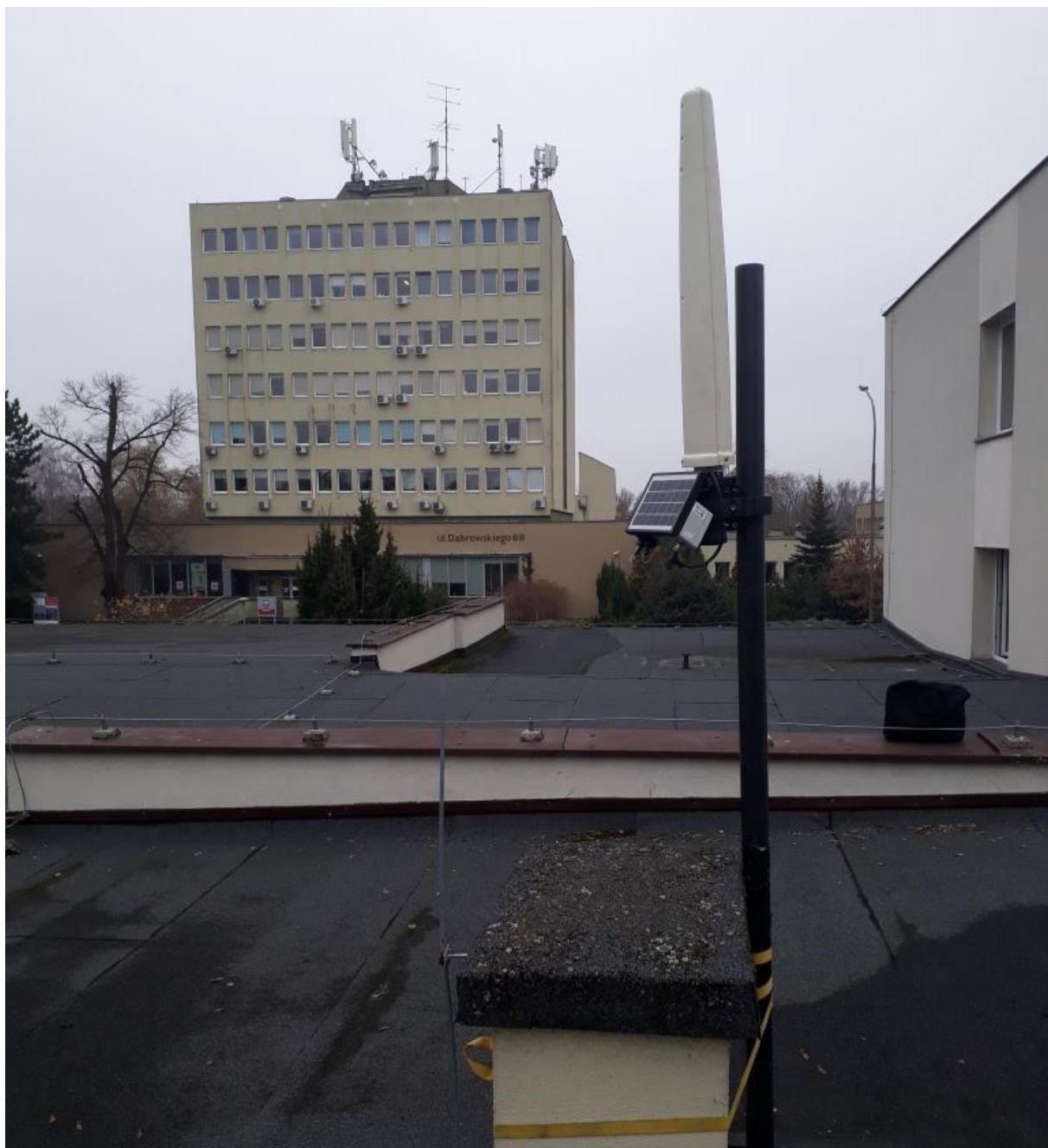
Rys. 3 Miejsce montażu SMS PEM – Zespół Szkół im. Staszica w Pile – widok na SBTK
