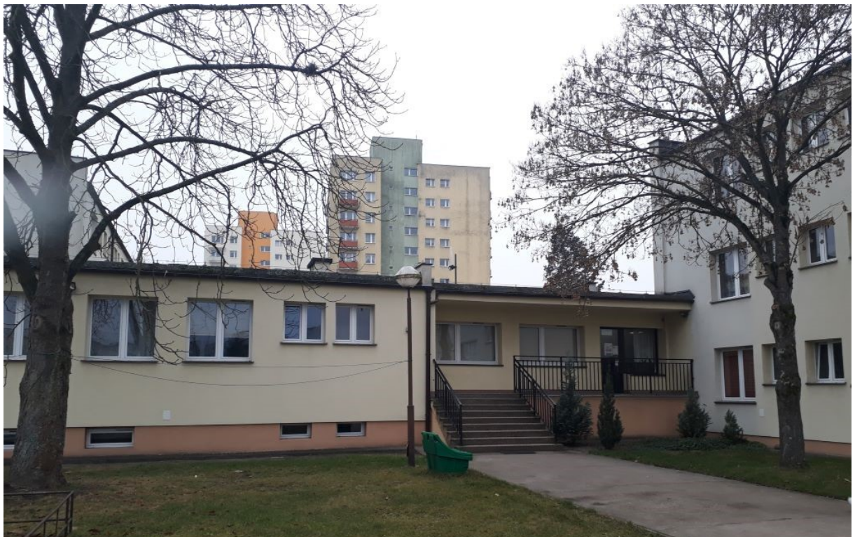
Rys. 2 Miejsce montażu SMS PEM – Zespół Szkół im. Staszica w Pile – widok z poziomu gruntu
