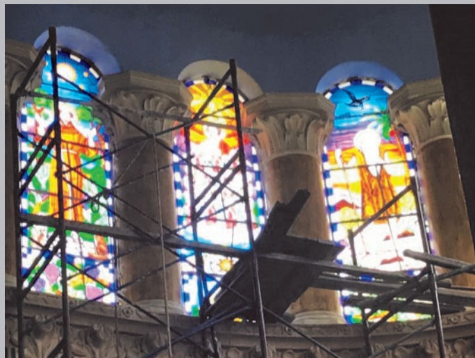
Dzieło ks. Kazimierza – instalacja nowych witraży w kościele św. Marka na Szubrze. Projekt: J. Dłużewski.
