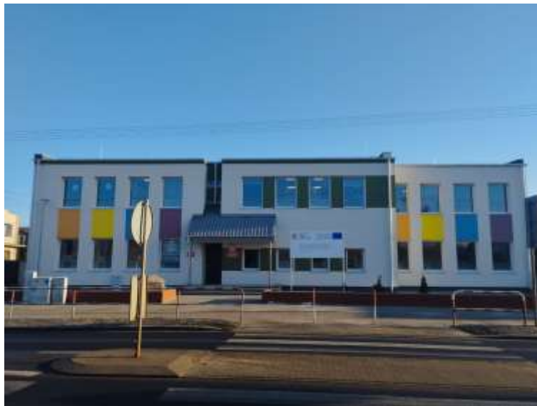
Zdjęcie nr 3. Wyremontowany budynek Zespołu Szkół Specjalnych im. Marii Konopnickiej zlokalizowany w Kielczewie
