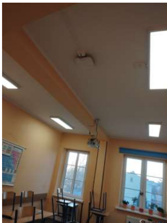
Zdjęcie nr 1. Zmodernizowane oświetlenie w Zespole Szkół Specjalnych im. Marii Konopnickiej w Kościanie – sala lekcyjna
