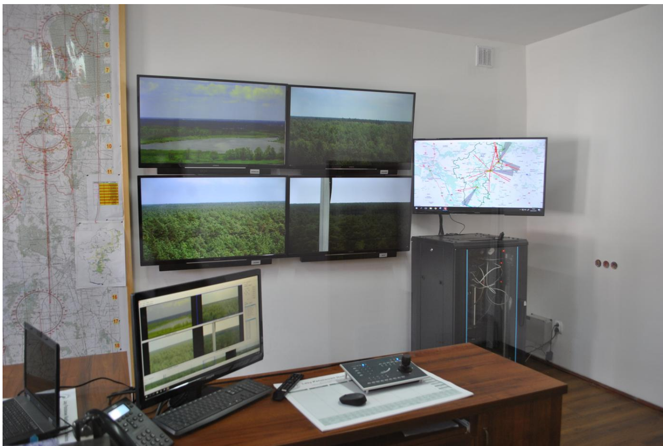
Punkt Alarmowo-Dyspozycyjny w Nadleśnictwie Skrwilno
