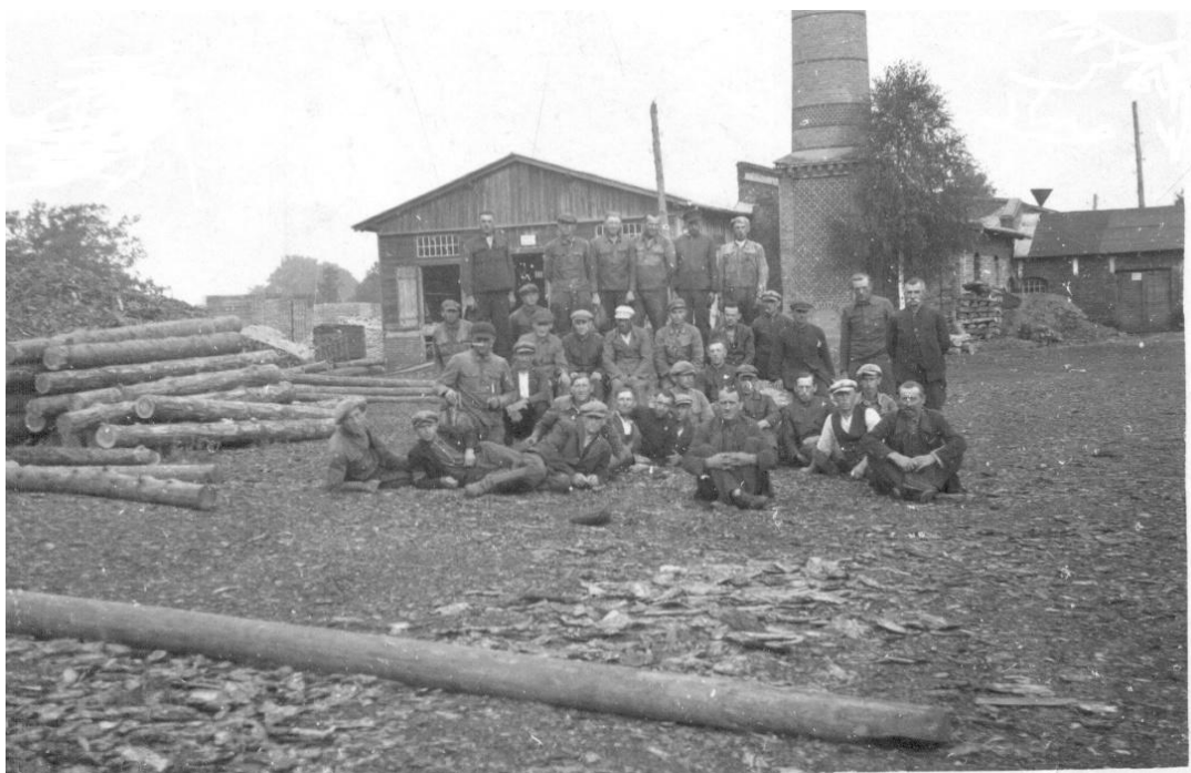
Budynek tartaku parowego, pochodzącego z roku 1874
