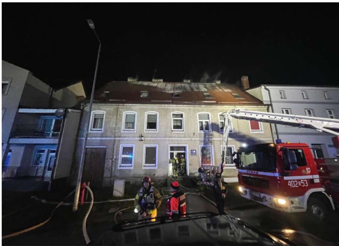
Fot. 4 Pożar budynku wielorodzinnego
