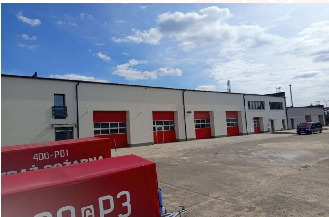
Fot. 34 Budynek warsztatowo-magazynowy KP PSP w Bytowie - rok 2025
