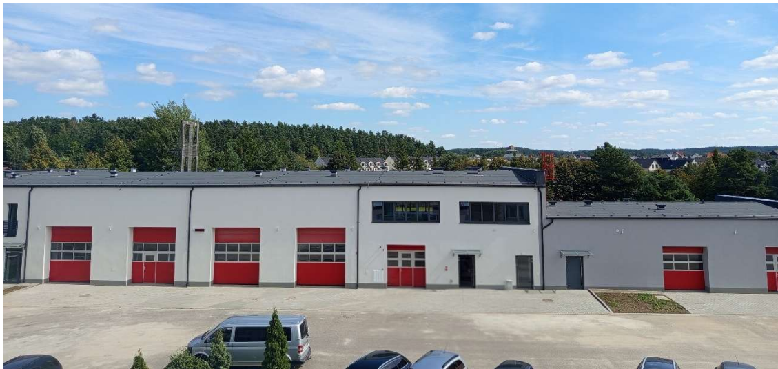
Fot. 33 Budynek warsztatowo-magazynowy KP PSP w Bytowie - rok 2025
