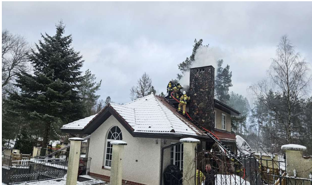
Fot. 1 Pożar budynku jednorodzinnego
