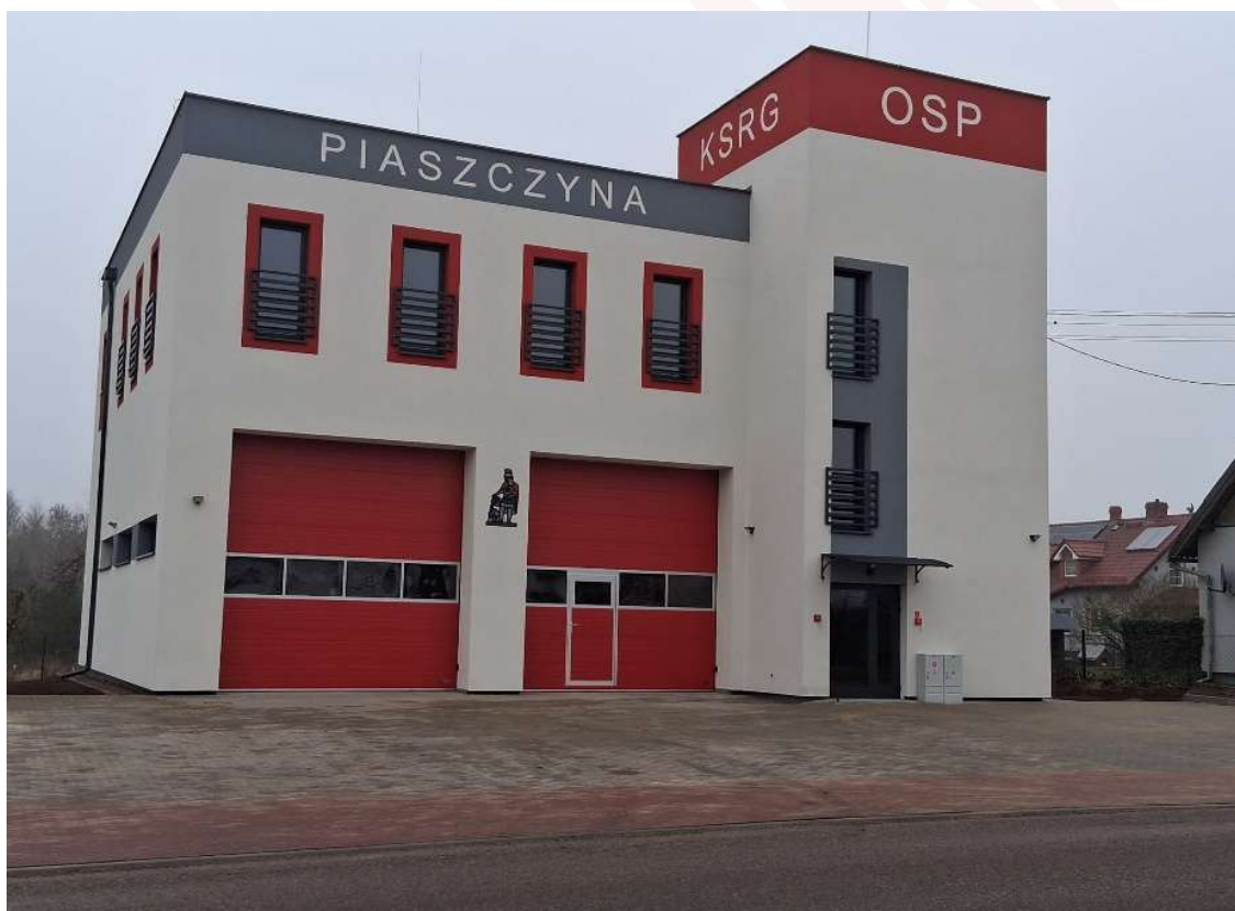
Fot. 48 Remiza OSP Piaszczyzna
