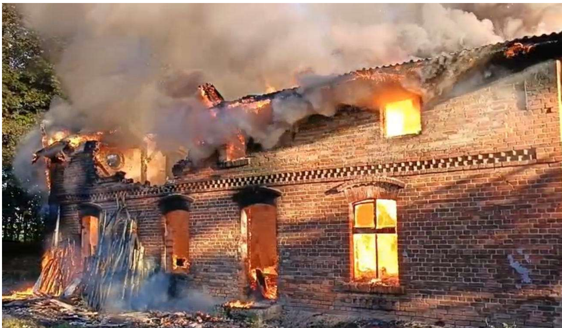
Fot. 8 Pożar budynku jednorodzinnego w Udorpiu
