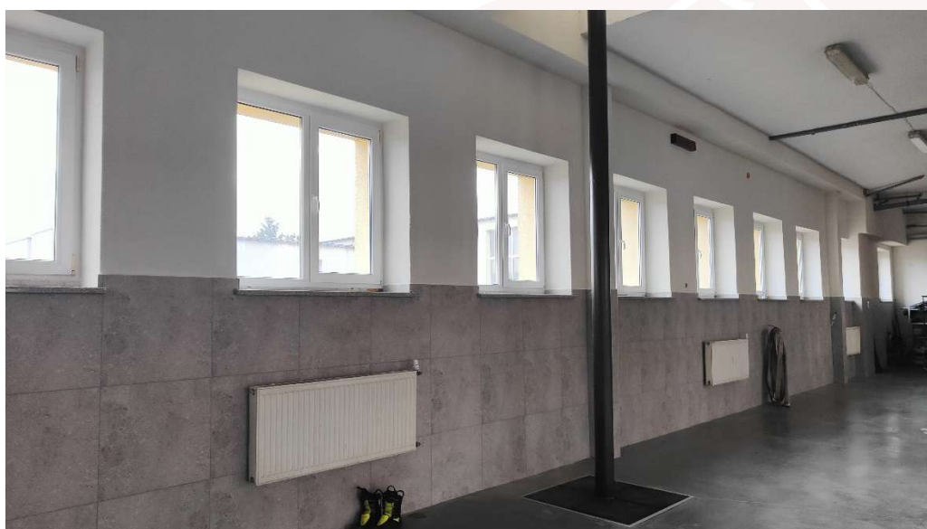
Fot. 43 Pomieszczenie garażowe JRG Nr 2 w Miastku
