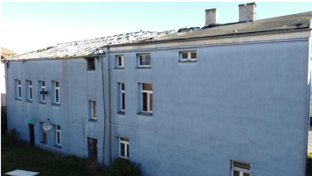
Zdjęcie 1 Elewacja zachodnia budynku
