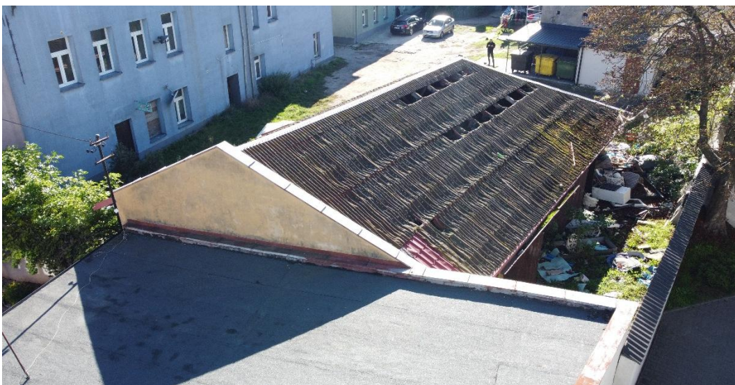
Zdjęcie 15 Widok budynku gospodarczego. Budynek obstawiny różnego rodzaju zbędnymi przedmiotami (teren zaśmiecony)
