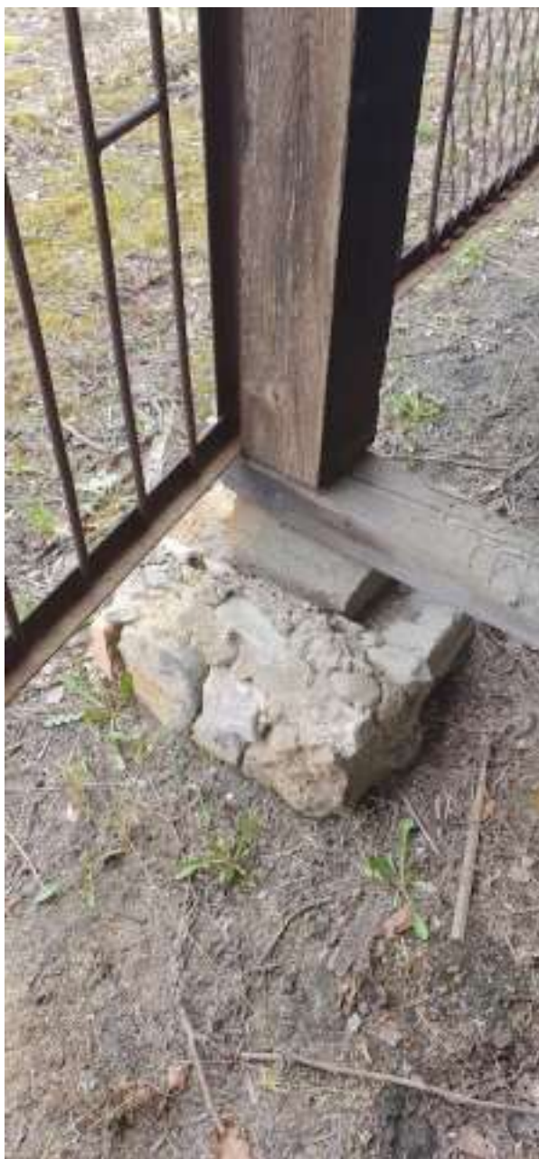
Stopy fundamentowe pod słupami drewnianymi
