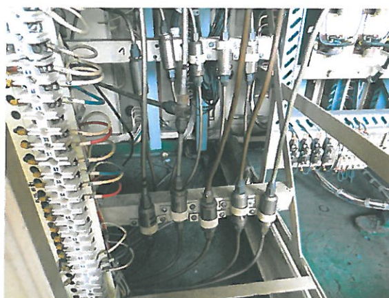
Zdjęcie 15. Filtry powietrza w panelu mostkowym na rurociągach pneumatycznych
