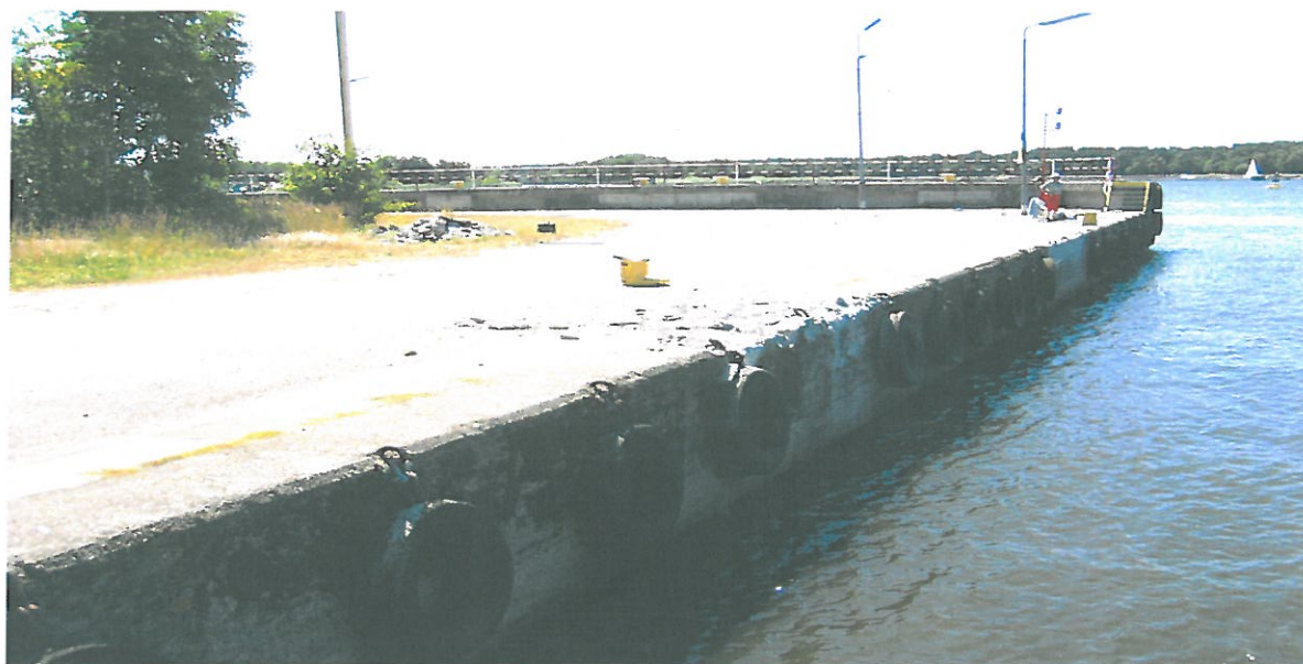
Zdjęcie 20. Zużyte opony samochodowe użyte jako odbijacze przy nabrzeżu
