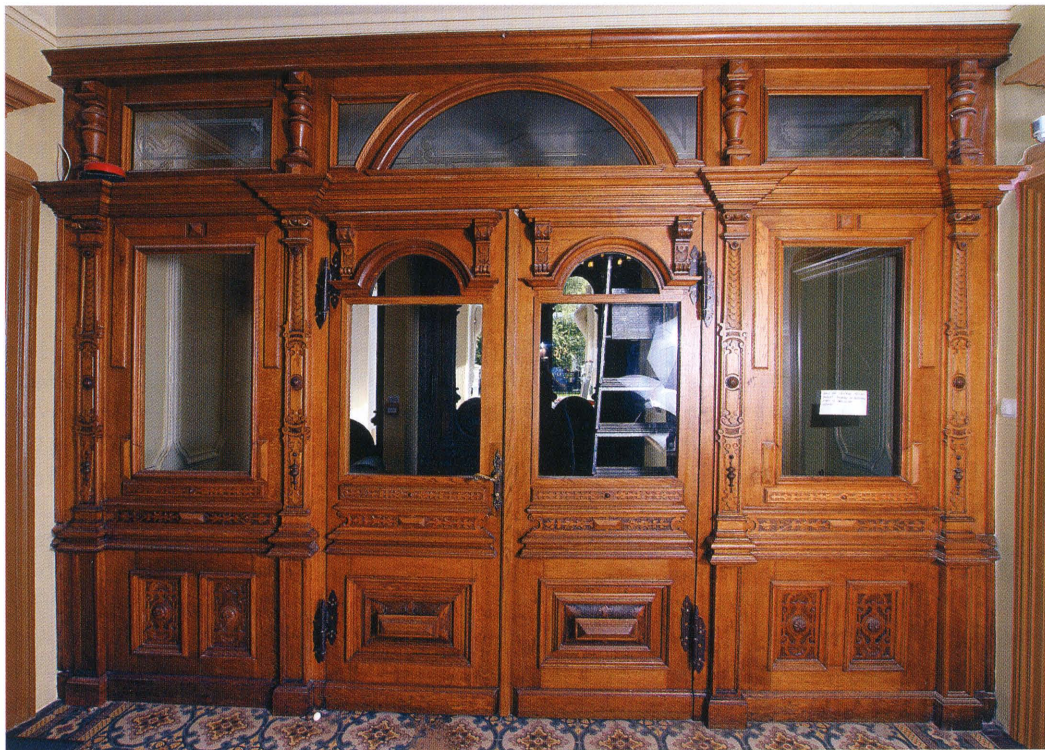
41-42. Stolarzownia korytarza pierwszej kondygnacji pałacu po konserwacji. Fot. K. Michałowski. Carpentry in the hall on the palace first storey after conservation. Photo: K. Michałowski.
