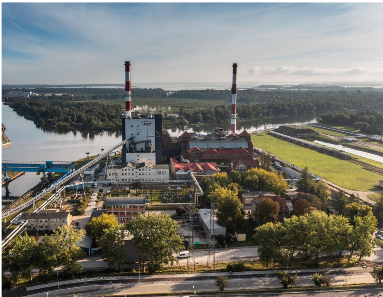
Fot.1 Elektrociepłownia Szczecin. Materiały własne.
