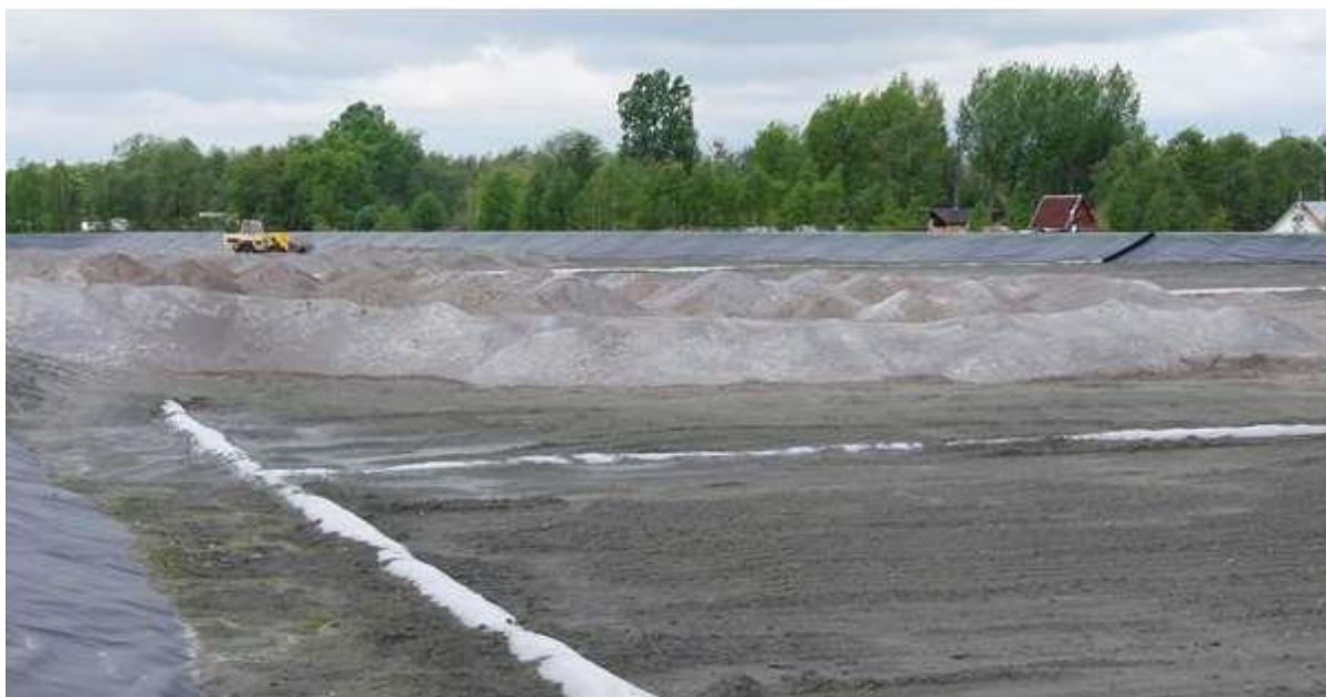
Fot.2 Składowisko odpadów Elektrociepłowni Szczecin. Materiały własne.
