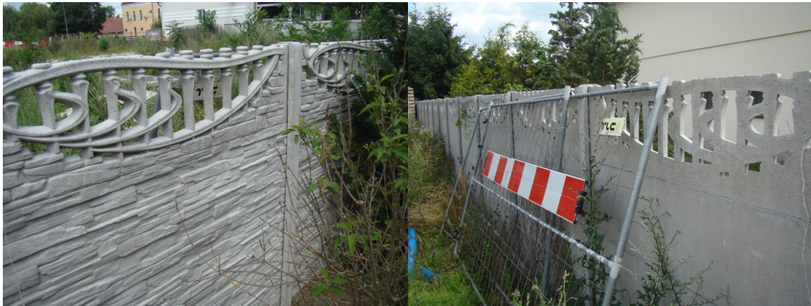
Fot. numer 12 i numer 13: Fragment ogrodzenia wybudowanego w ramach Inwestycji
