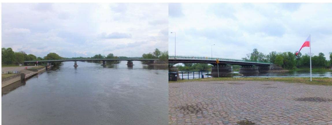
Fot. numer 1 i numer 2: Przebudowany most w stanie poprzedzającym realizację Inwestycji
