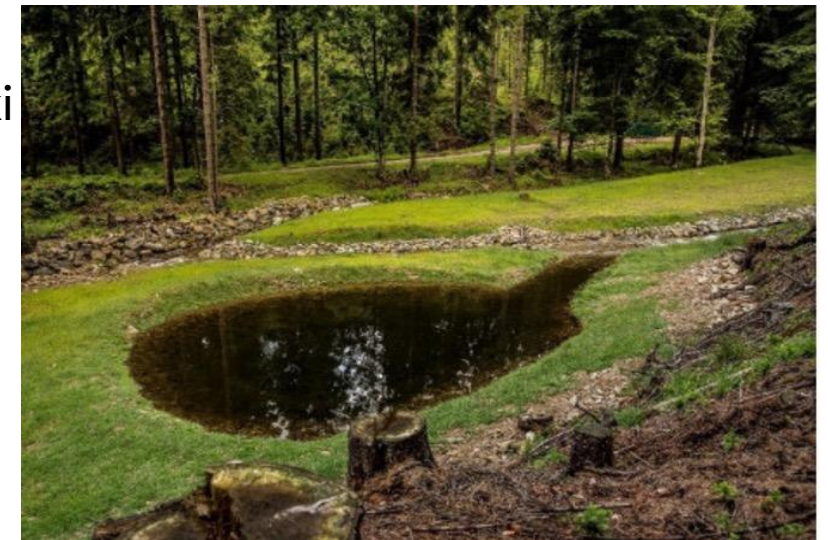
Widok na zaporę czołową dawnego zbiornika na cieku do spławu drewna przerobionego na zbiornik przeciwpowodziowy – Nadleśnictwo Międzylesie. Źródło: Archiwum CKPŚ
