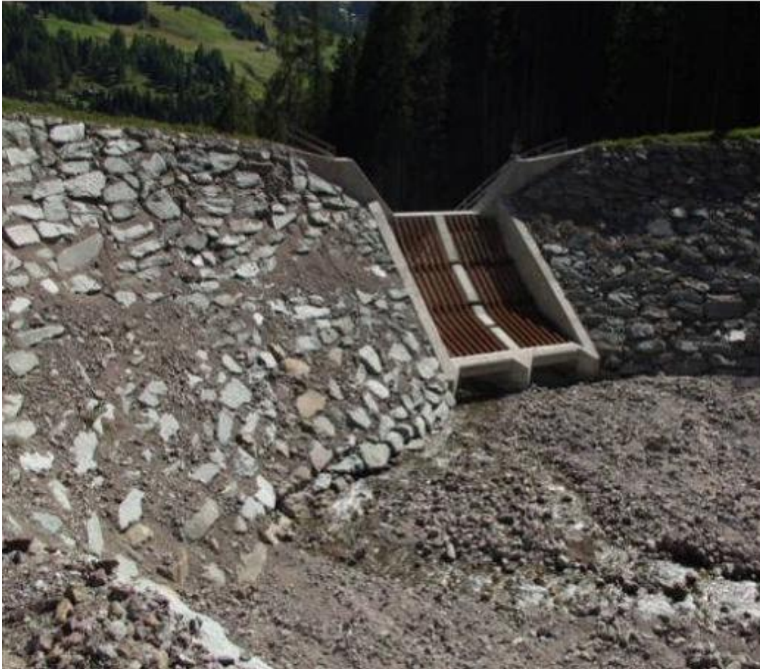
Przykłady zapór przeciwrumowiskowych szczelinowych w Austrii.
