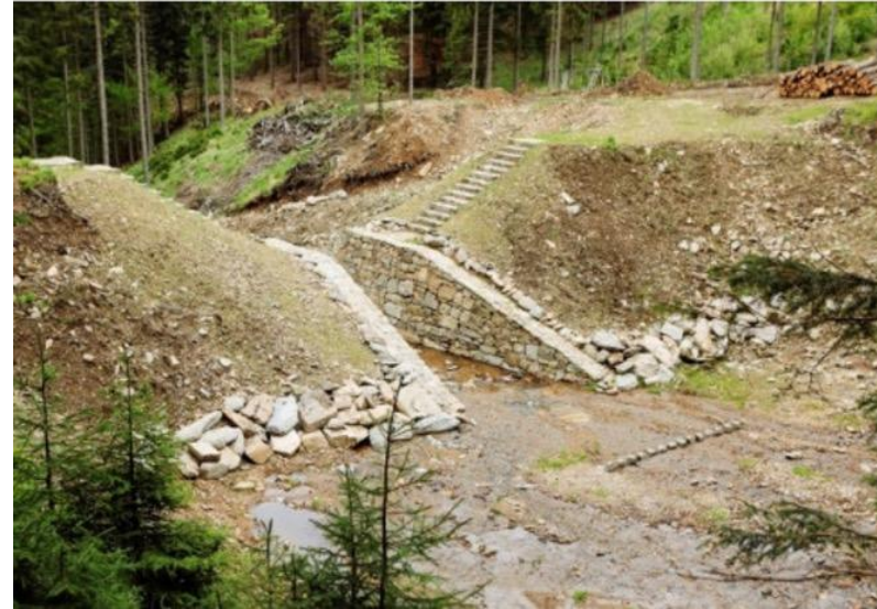
Widok na zaporę czołową dawnego zbiornika na cieku do spławu drewna przerobionego na zbiornik przeciwpowodziowy – Nadleśnictwo Międzylesie. Źródło: Archiwum CKPŚ
