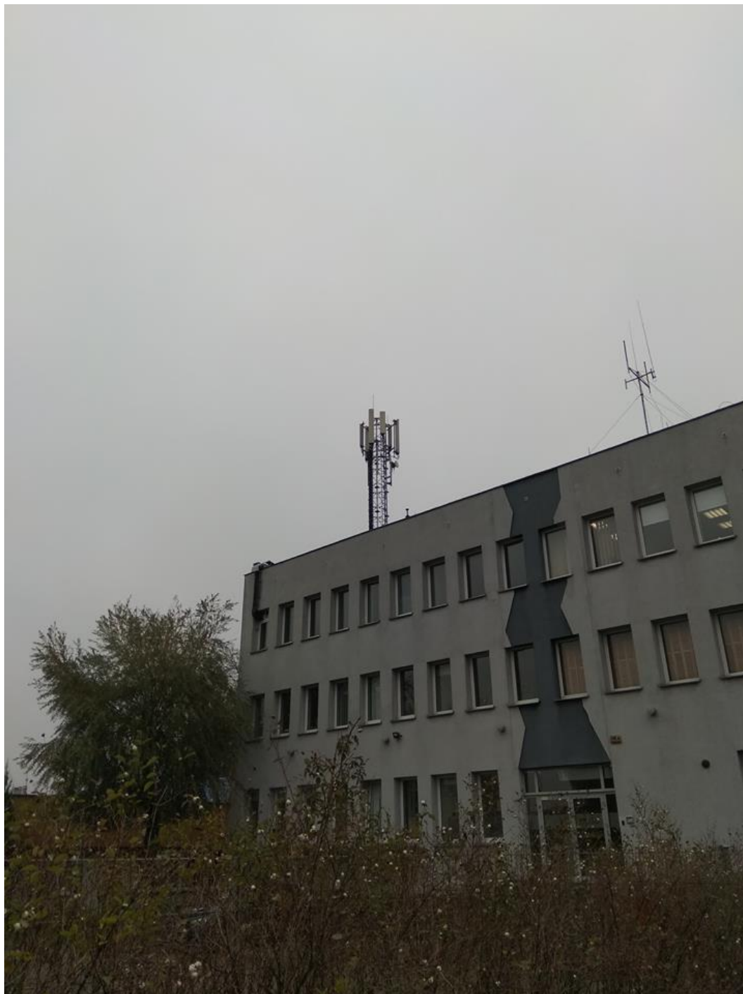
Fot. 1: Widok anten stacji bazowej: ID 5180 / 61558, zlokalizowanej przy ul. Zjednoczenia 118a w Zielonej Górze
