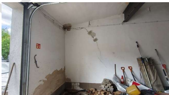
Rys. schematyczny przebieg zarysowań na ścianie wewnętrznej, poprzecznej
