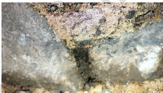
Fot. Odkrywka nr 2 – Fundament w dolnej części
