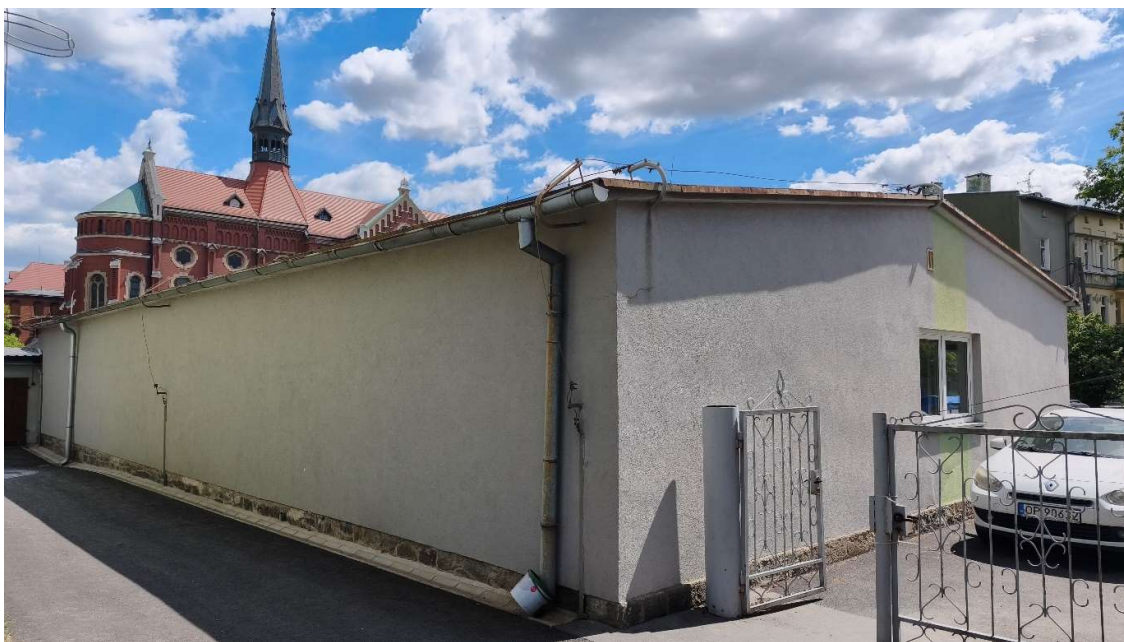
Fot. Przedmiotowy obiekt
