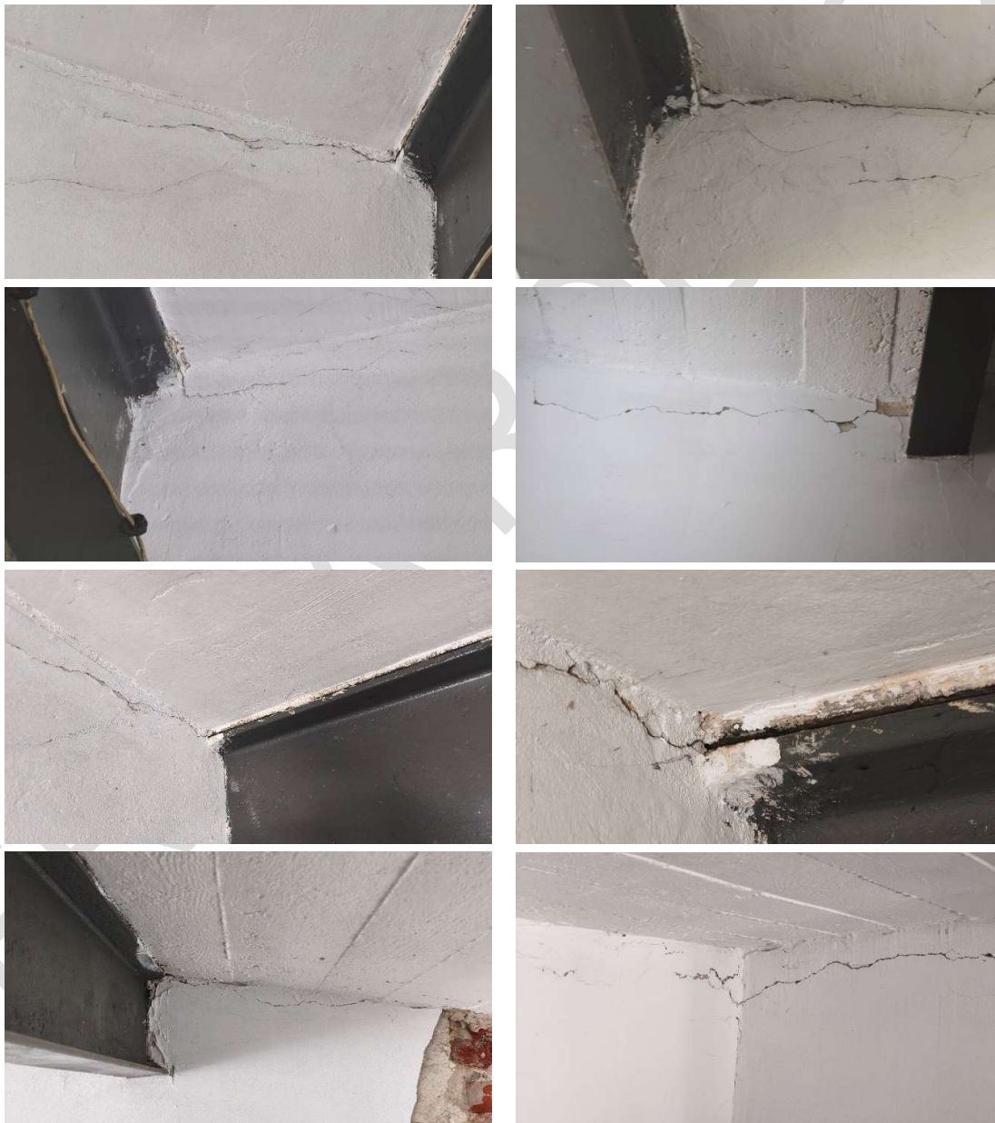
Rys. Zarysowania powstałe w obrębie oparcia belek stalowych na murze
