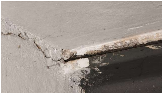
Fot. Zarysowania pod belkami stalowymi
