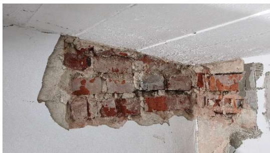
Fot. Zarysowania powstałe w narożach ze ścianą zewnętrzną - szczegóły
