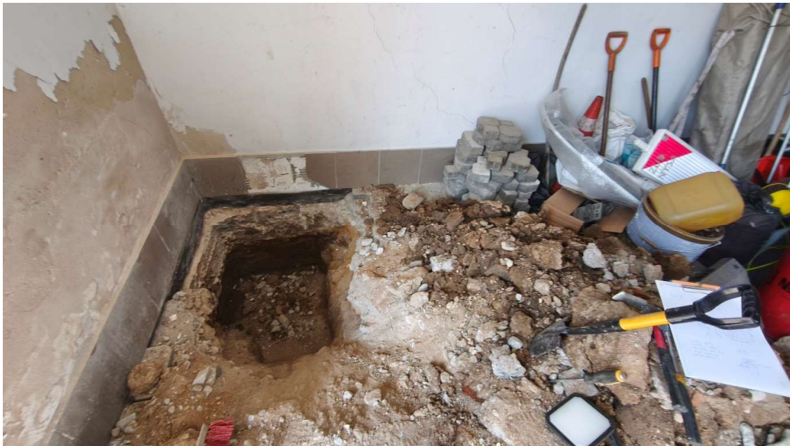
Fot. Ława fundamentowa – odkrywka
