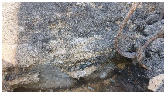
Fot. Odkrywka nr 2 – Fundament w górnej części
