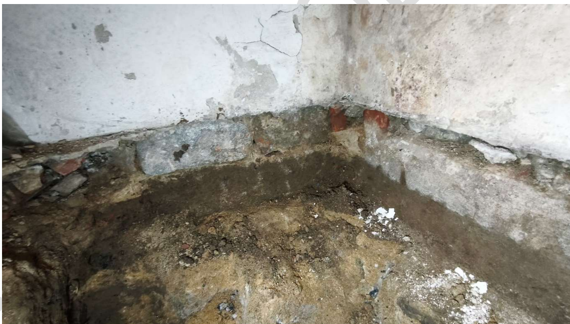
Fot. Ława fundamentowa – odkrywka
