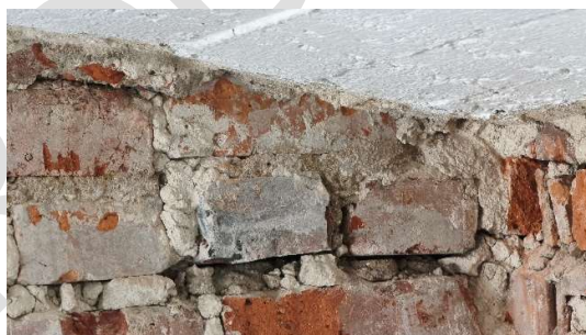
Fot. Zarysowania powstałe w narożach ze ścianą zewnętrzną - szczegóły
