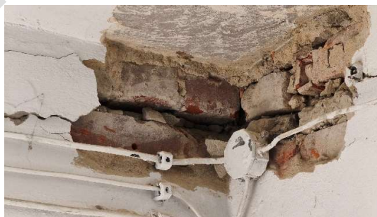
Fot. Brak wieńca w miejscu styku ściany zewnętrznej z płytą żelbetową dachu
