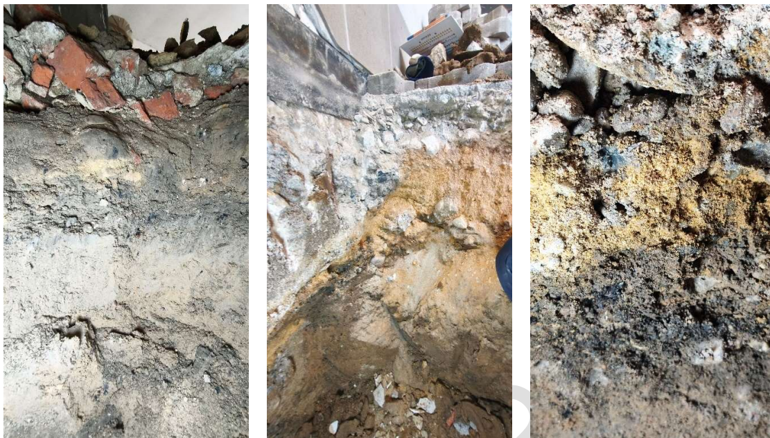
Rys. Warstwy posadzki
