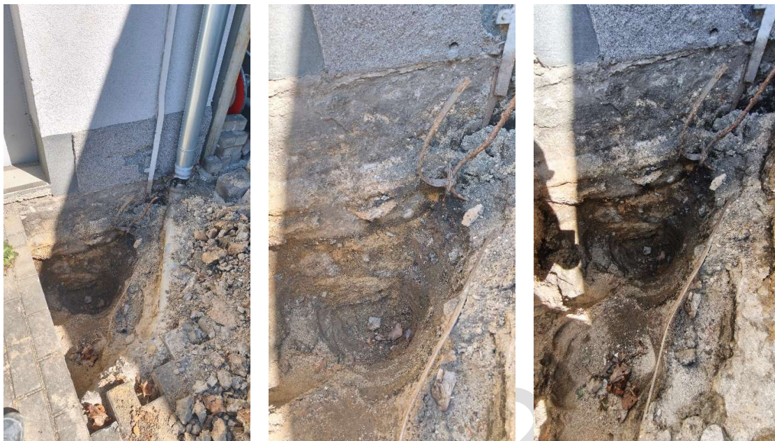
Fot. Miejsce wykonania odkrywki nr 3
