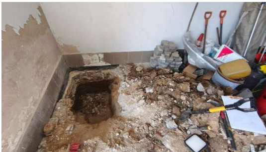
Fot. Miejsce wykonania odkrywki nr 1
