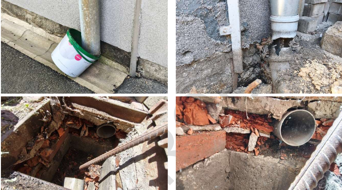
Fot. Ściana od strony południowej
