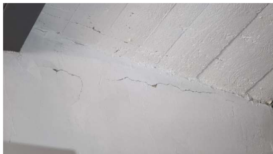
Fot. Zarysowania powstałe w narożach ze ścianą zewnętrzną - szczegóły
