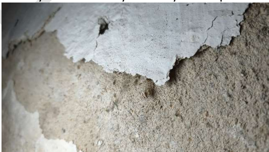
Fot. Zawilgocenia ściany murowej
