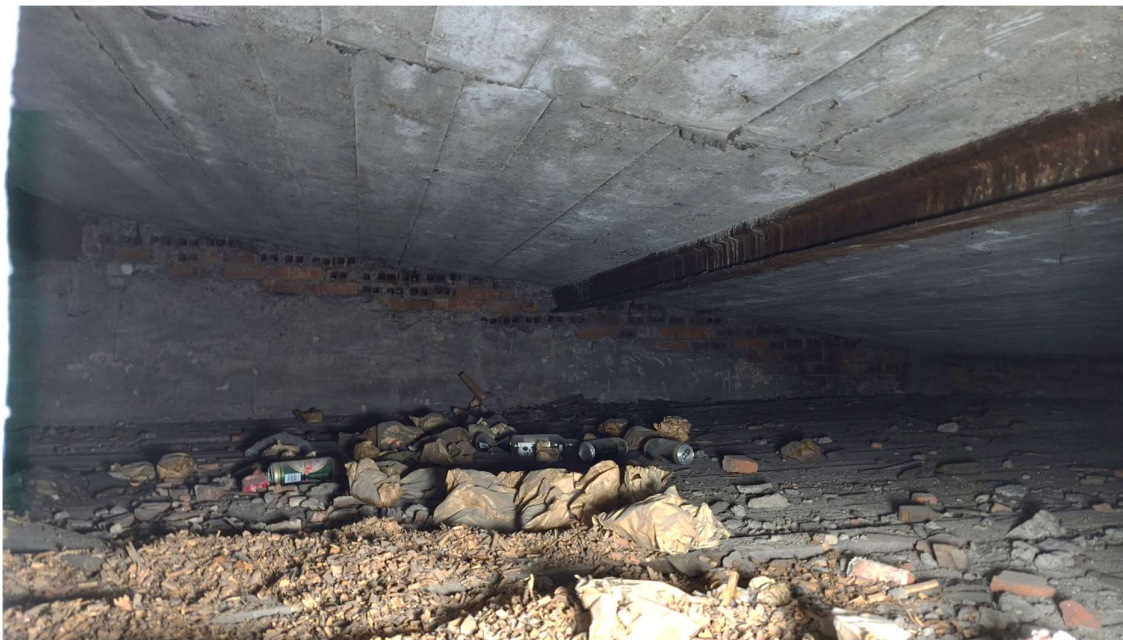
Fot. Strefa stropodachu nad skrajnym pomieszczeniem
