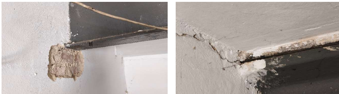
Rys. Zarysowania powstałe w obrębie oparcia belek stalowych na murze
