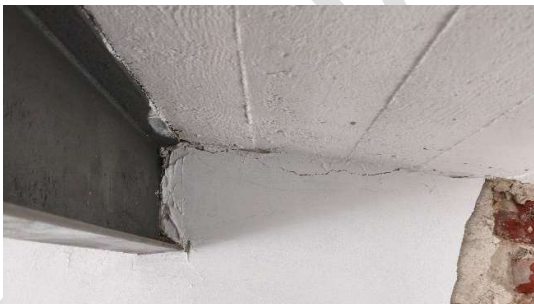
Fot. Zarysowania na styku ściany ze stropem
