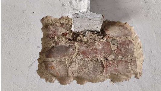
Fot. Zarysowania pod belkami stalowymi
