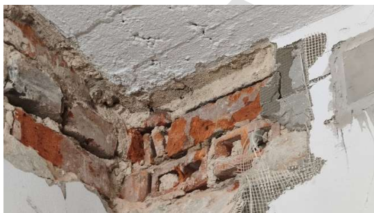
Fot. Brak wieńca w miejscu styku ściany zewnętrznej z płytą żelbetową dachu
