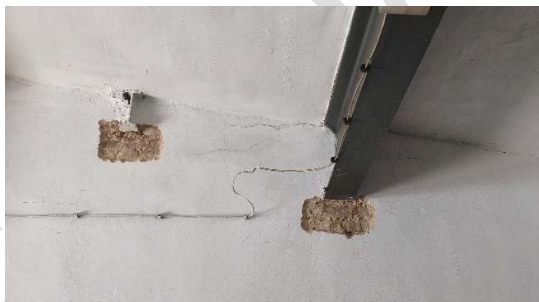
Fot. Zarysowania powstałe w narożach ze ścianą zewnętrzną - szczegóły
