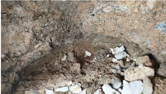
Fot. Odkrywka nr 1 – Fundament w górnej części
