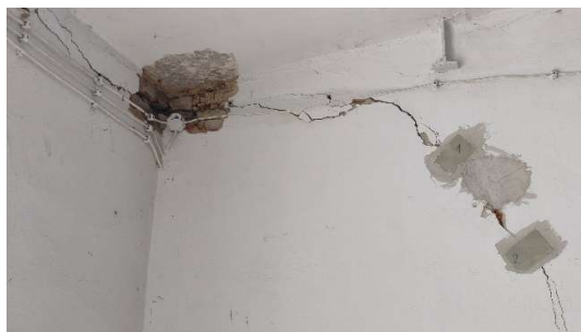
Rys. schematyczny przebieg zarysowań na ścianie wewnętrznej, poprzecznej
