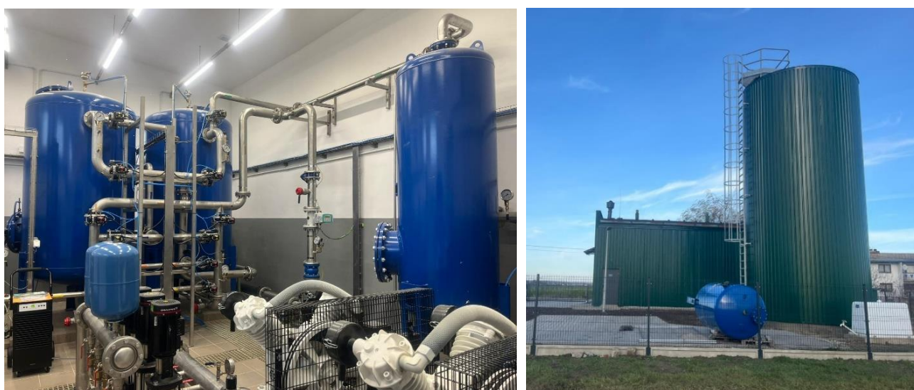
Rys. 2. Wodociąg Trębaczów (powiat kępiński)
