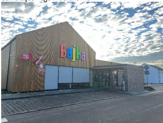
Rys. 4. Budynek Publicznego Przedszkola Samorządowego w Baranowie
