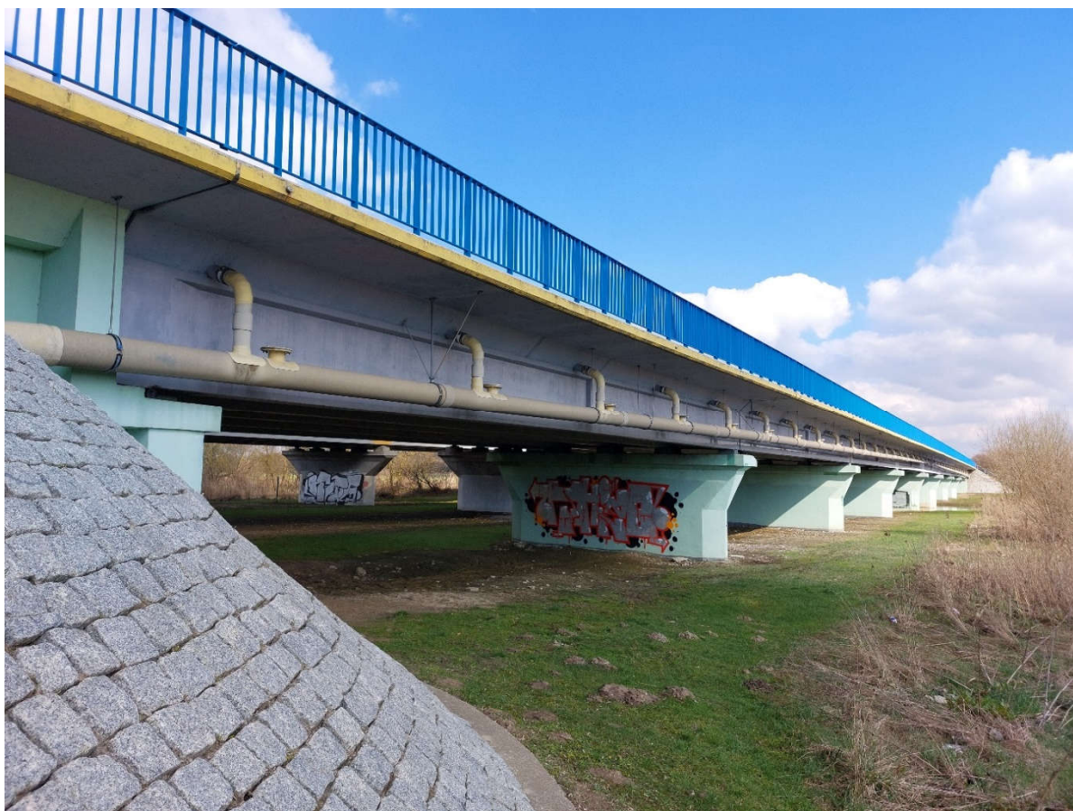
Fot. 1. Widok z boku, ujęcie od przyczółka od m. Warszawa - strona prawa.
