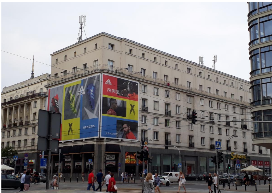
Fot. 1: Widoki anten stacji bazowej ID: WAR1092C, zlokalizowanej przy ul. Kruczej 51 w Warszawie
