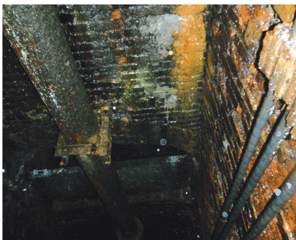
► Rys. 4. Widok ociosu szybu na odcinku w przekroju prostokątnym
