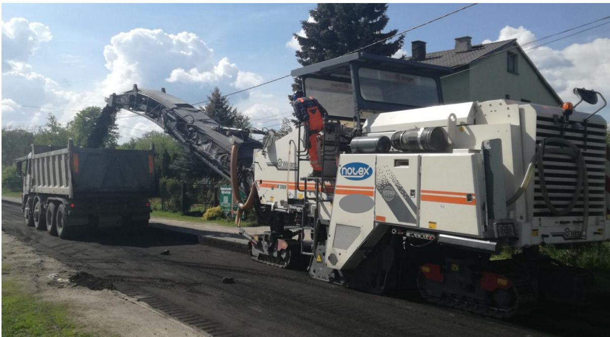
Rys. 5.2.2.1. Przykład frezowania nawierzchni na całej powierzchni
