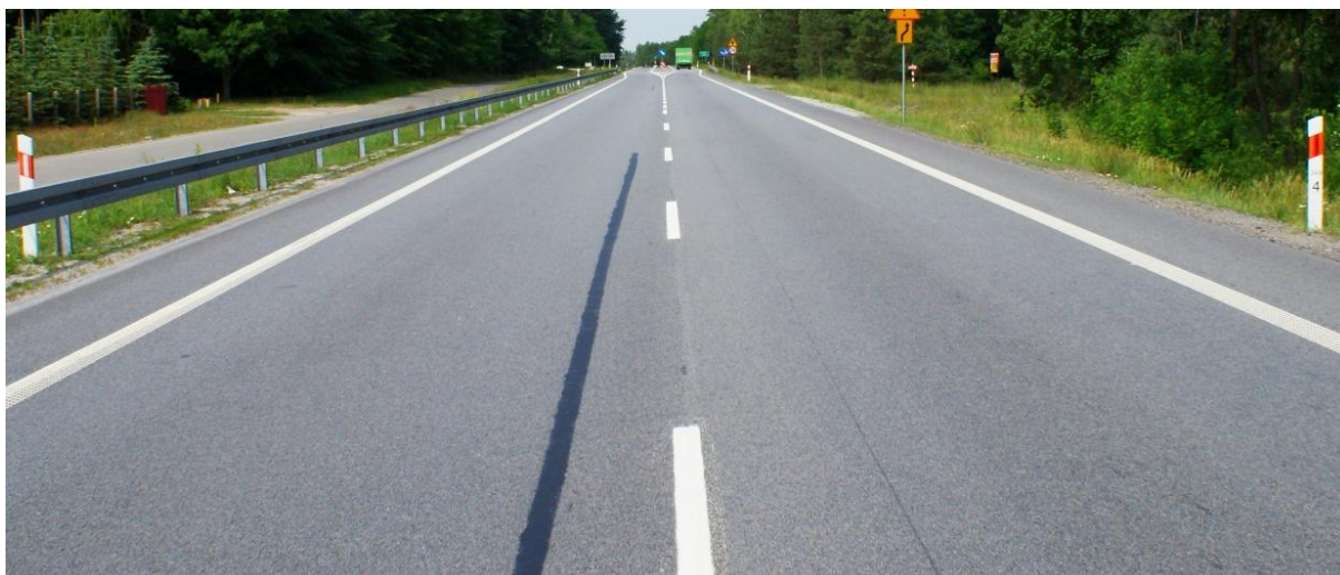
Rys. 5.12.1.2. Przykład wypełnienia spękania metodą pasmową bez rozfrezowania
