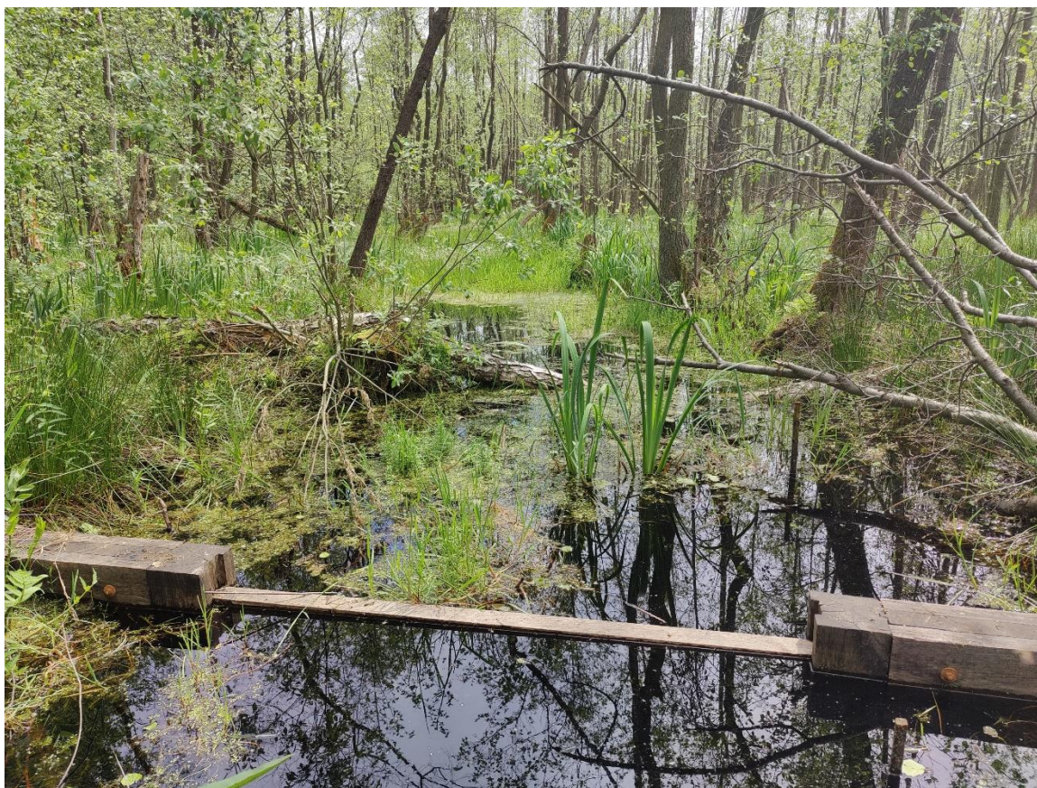
Rysunek VI.7 Drewniana zastawka z możliwością regulacji poziomu piętrzenia w zakresie \pm 0,4 m, zlokalizowana na cieku w Kampinoskim Parku Narodowym. Fotografia: Mateusz Grygoruk.
