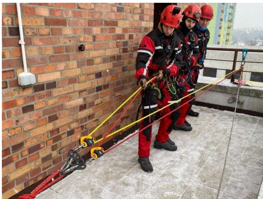
Zdjęcie 9. Układ wyciągowy 1:1 (wyciąganie siłowe, bloker – Pro Traxion)
