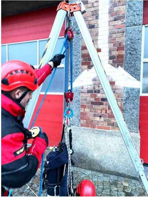
Zdjęcie 19. Układ wyciągowy 4:1 na trójnogu, praca rąk
