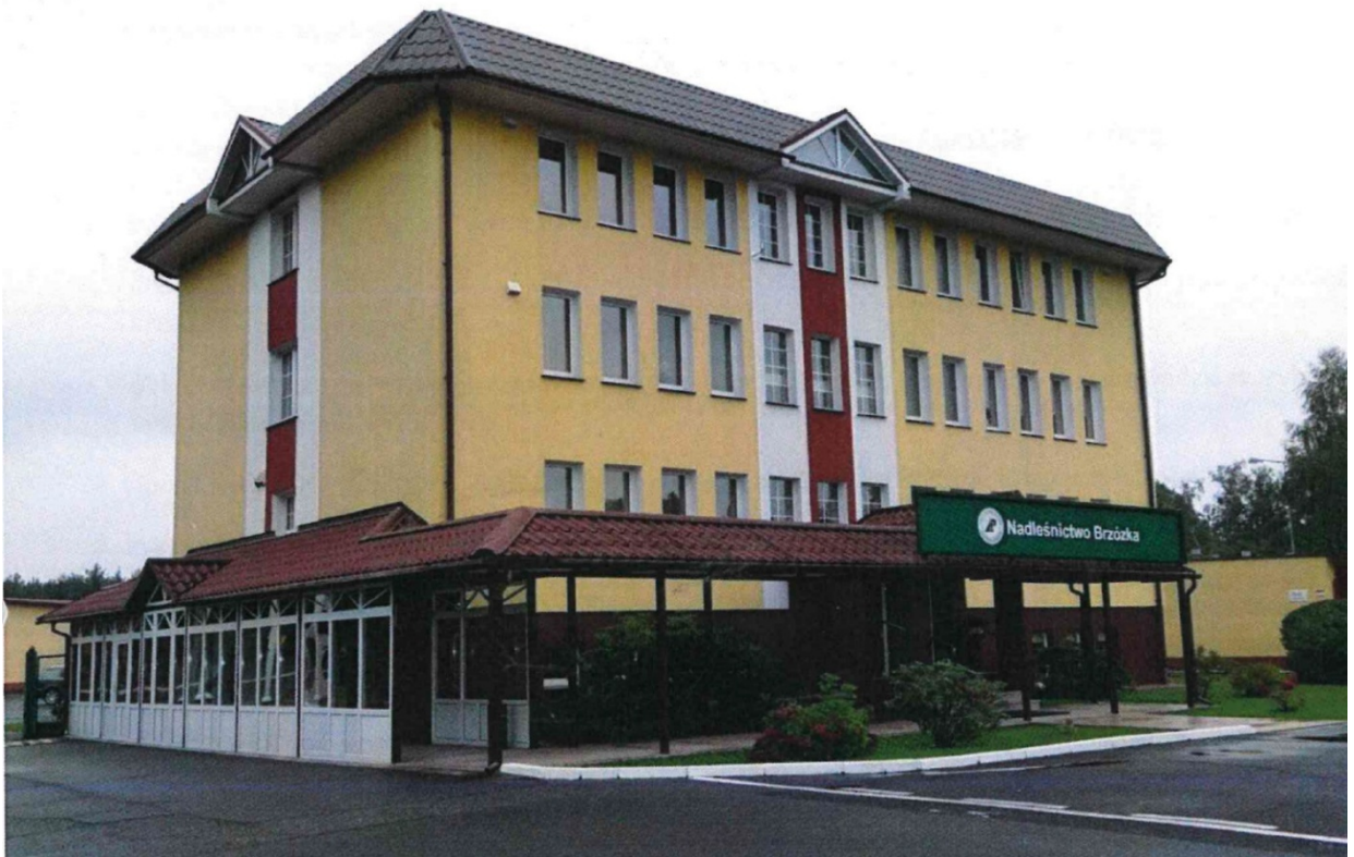
Budynek administracyjny Nadleśnictwa
