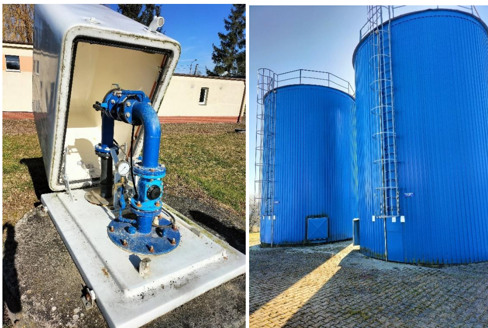
Widok stacji uzdatniania wody, studni oraz zbiorników wyrównawczych
