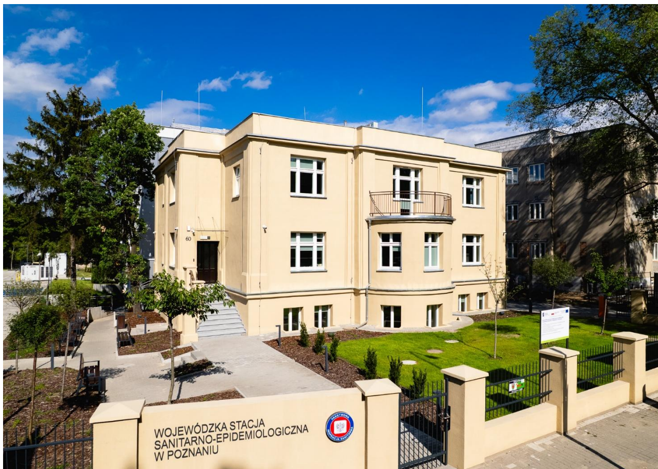
Rys. 4. Rozbudowa Laboratorium Mikrobiologii i Parazytologii Wojewódzkiej Stacji Sanitarno-Epidemiologicznej w Poznaniu z utworzeniem laboratorium BSL3
