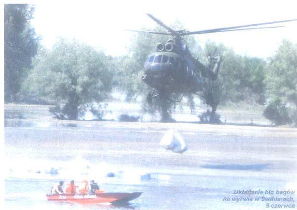
Układanie big bagów na wyrwie w Świnarach 5 czerwca
