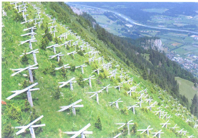
Ciekawy sposób aktywnego zabezpieczenia stoku przed zejściem lawiny w sezonie zimowym fot. Pixabay
