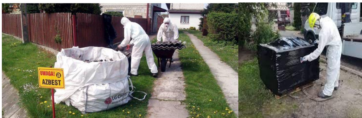
Fot. 2. Prace podczas usuwania azbestu
