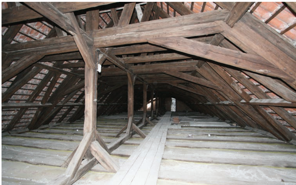
2. Widok ogólny wieżby dachu nad nawą główną katedry w Łomży. Fot. M. Warchoń General view of the roof trusses over the nave of the cathedral in Łomża. Photo by M. Warchoń
