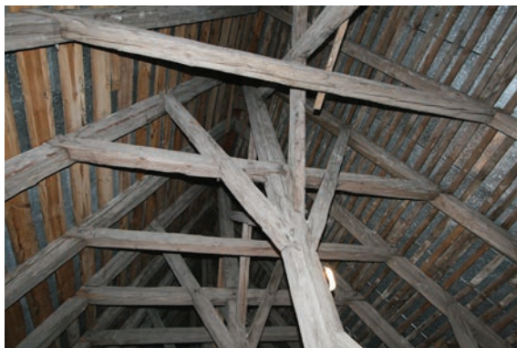
15. Widok więźby nad nawą główną kościoła w Szczepankowie. Fot. M. Warchoł View of rafter framing over the main nave of the church in Szczepankowo. Photo by M. Warchoł
