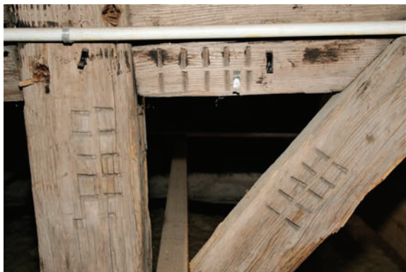
8. Ciesielskie oznaczenia montażowe na elementach wiązara więźby kościoła w Niedźwiadnej. Fot. M. Warchoł Carpentry installation marks on the elements of the truss of the church in Niedźwiadna. Photo by M. Warchoł
