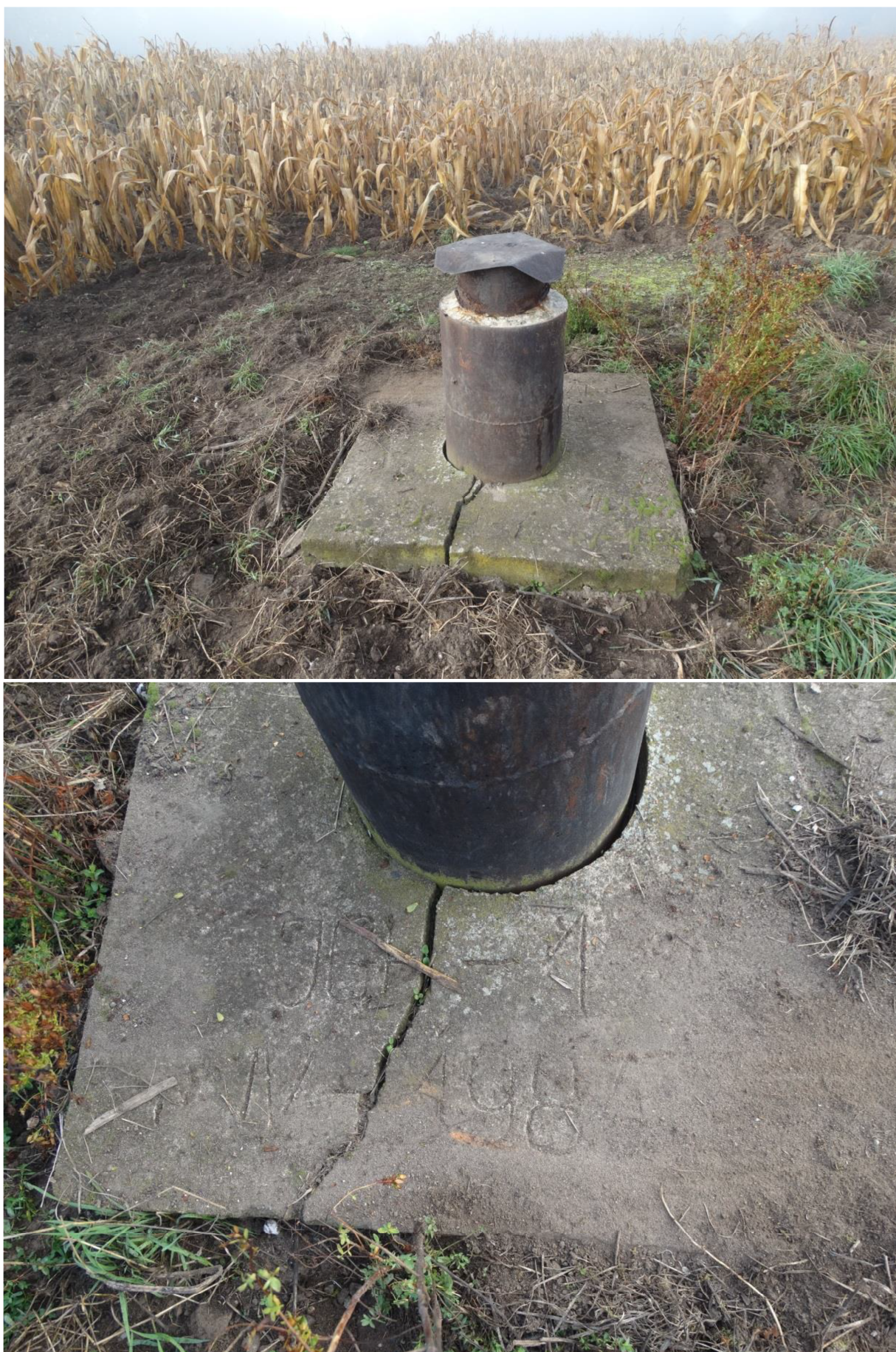
Rys. 19. Aktualny stan wylotu otworu Pobiedziska IGH-1 (fot. B. Bielec)
