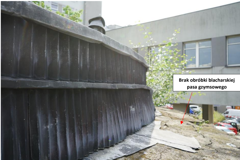
Pionowa obróbka blacharska ścianki attykowej .
