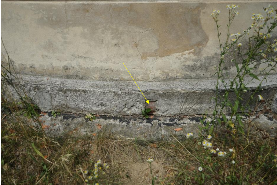
SCHODY WEJŚCIOWE – miejscowe uszkodzenia , odparzenia lastriko
