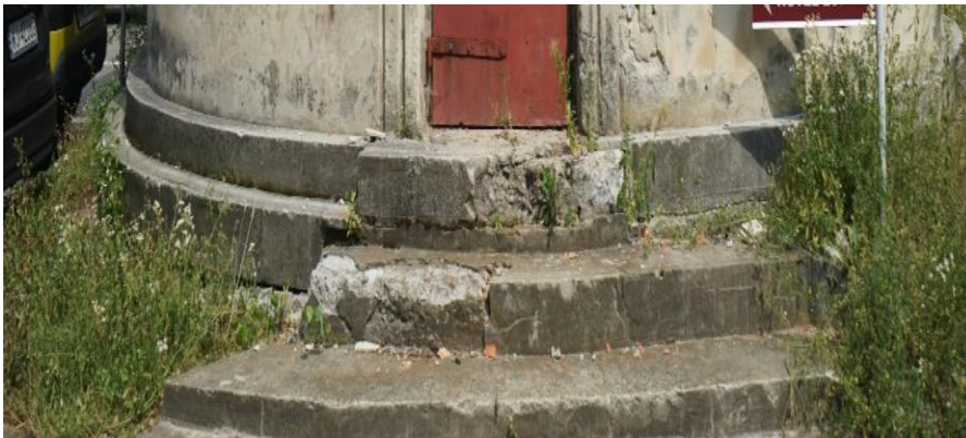
SCHODY WEJŚCIOWE – miejscowe uszkodzenia , odparzenia lastriko
