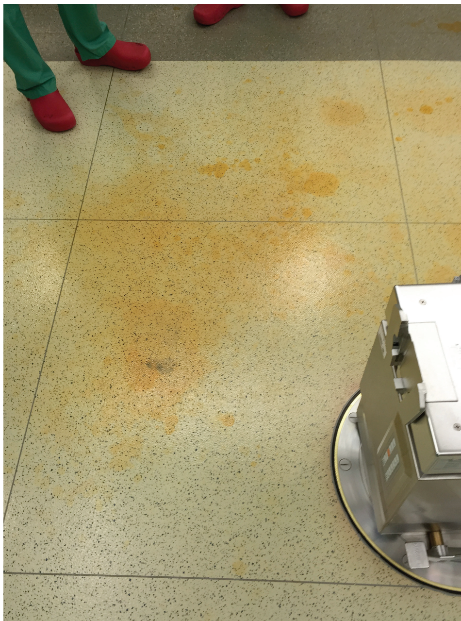
Ilustracja 6.5.4 Fragment wykładziny przy stole operacyjnym uszkodzonej przez środki dezynfekcyjne (materiały wykończeniowe powinny być dostosowane do używanych środków chemicznych), fot. autor, 2016 r.
