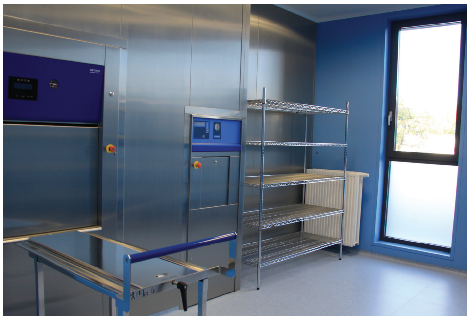
Ilustracja 6.4.3 Pomieszczenie centralnej sterylizacji (fizyczne oddzielenie części brudnej, czystej i jałowej pozwala ograniczyć możliwość wtórnej kontaminacji narzędzi), fot. autor, 2016 r.
