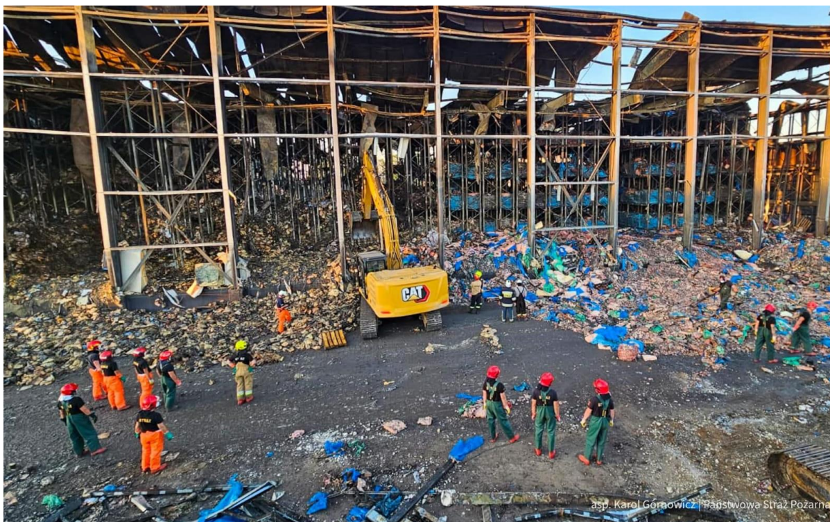
Zdjęcie – ciężki sprzęt podczas rozbiórki spalonej hali
