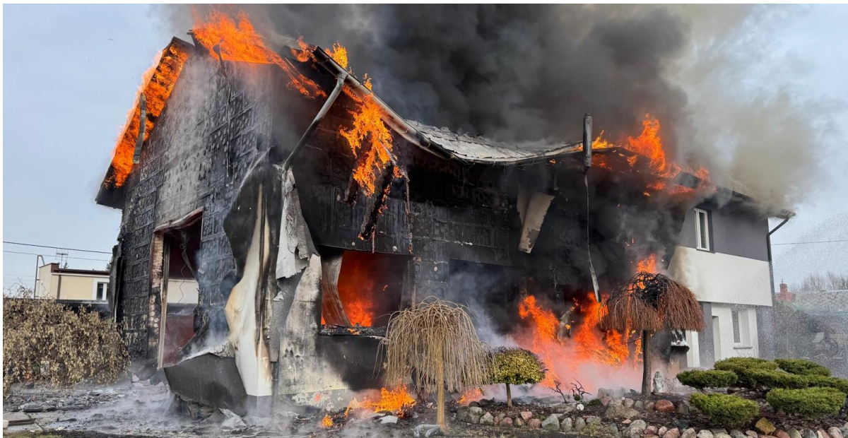
Zdjęcie – pożar budynku wielorodzinnego
