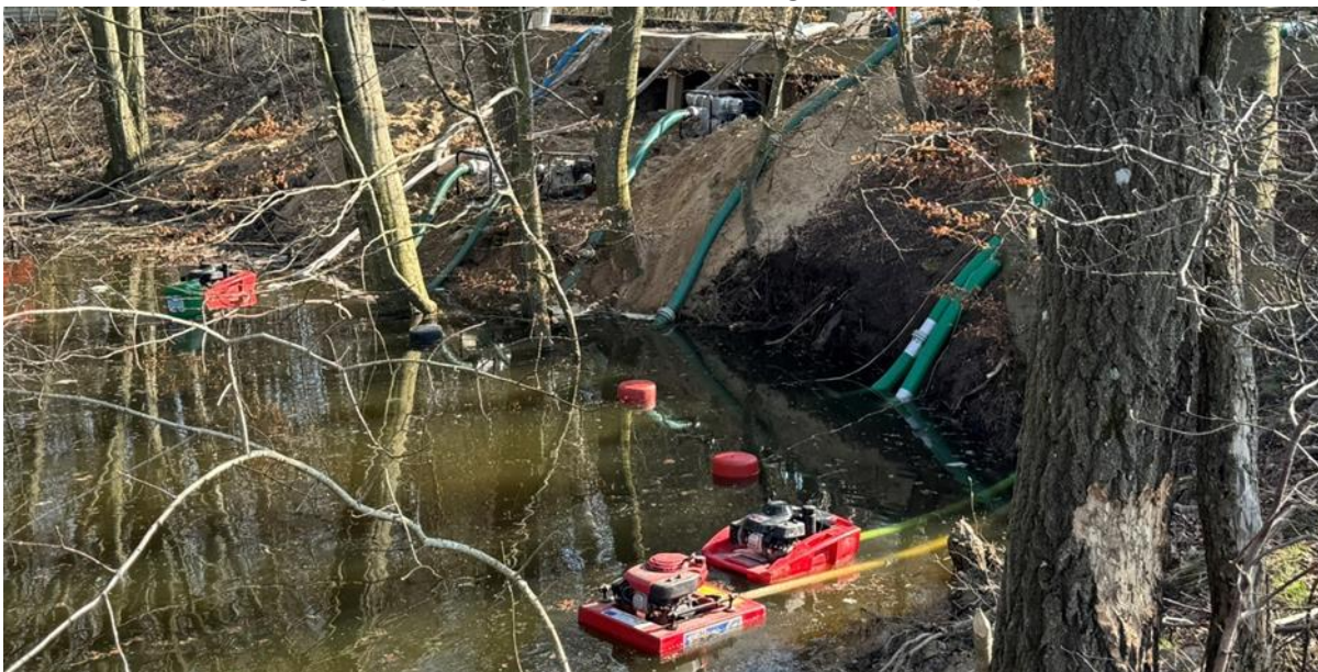
Zdjęcie – odpompowywanie wody przy niedrożnym przepuście
