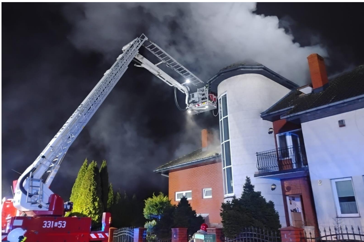
Zdjęcie – pożar poddasza w budynku jednorodzinnym
