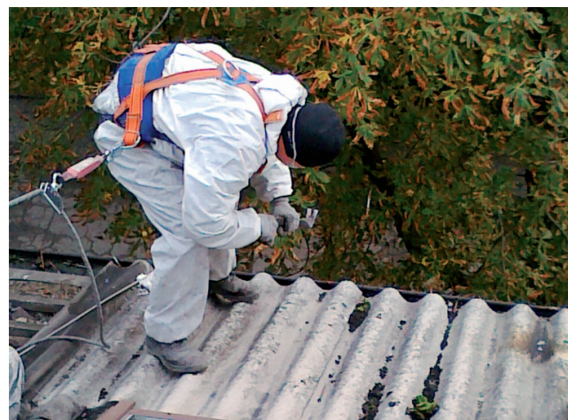
Fot. 3. Usuwanie materiałów zawierających azbest
