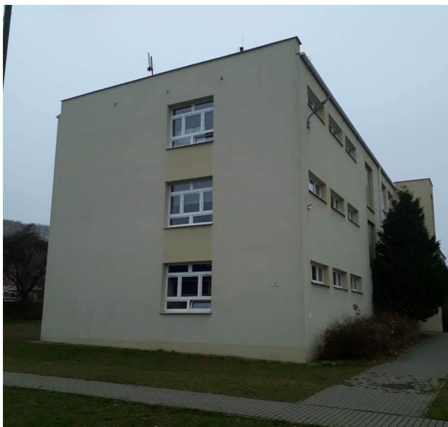
Rys. 2 Miejsce montażu SMS PEM – ZSET w Gdyni – widok z poziomu gruntu
