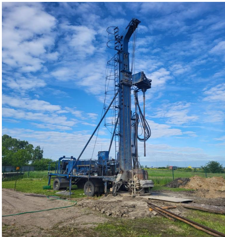
Wiercenie otworu studziennego nr 4 – Stacja Uzdatniania Wody Maryszewice.
