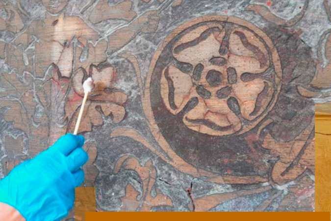
W trakcie konserwacji. Próby chemicznego usuwania szernie z powierzchni mocno zdegradowanego sgraffita (ul. Sobieskiego 5). Ze zbiorów autorki.
